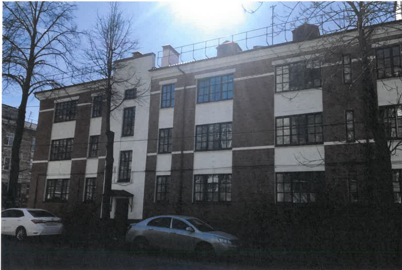
Существующее состояние главного фасада (фотофиксация).
