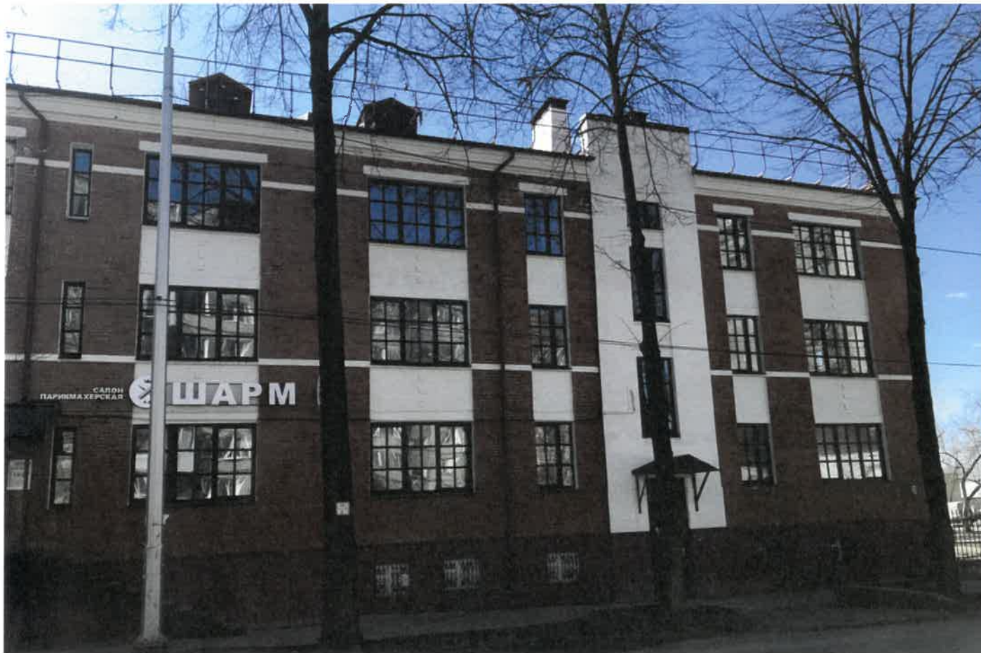
Существующее состояние главного фасада (фотофиксация).
