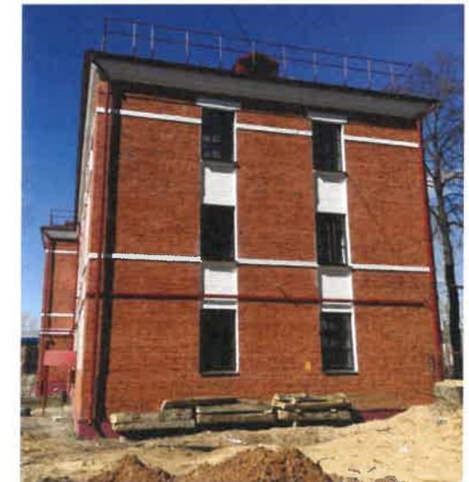
Существующее состояние бокового фасада (фотофиксация).
