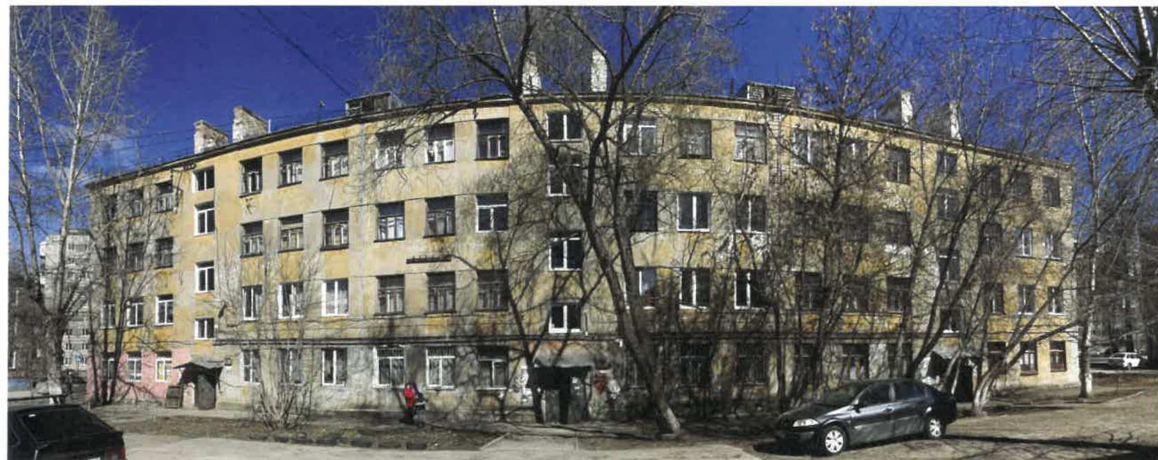
Существующее состояние дворового фасада (фотофиксация)
