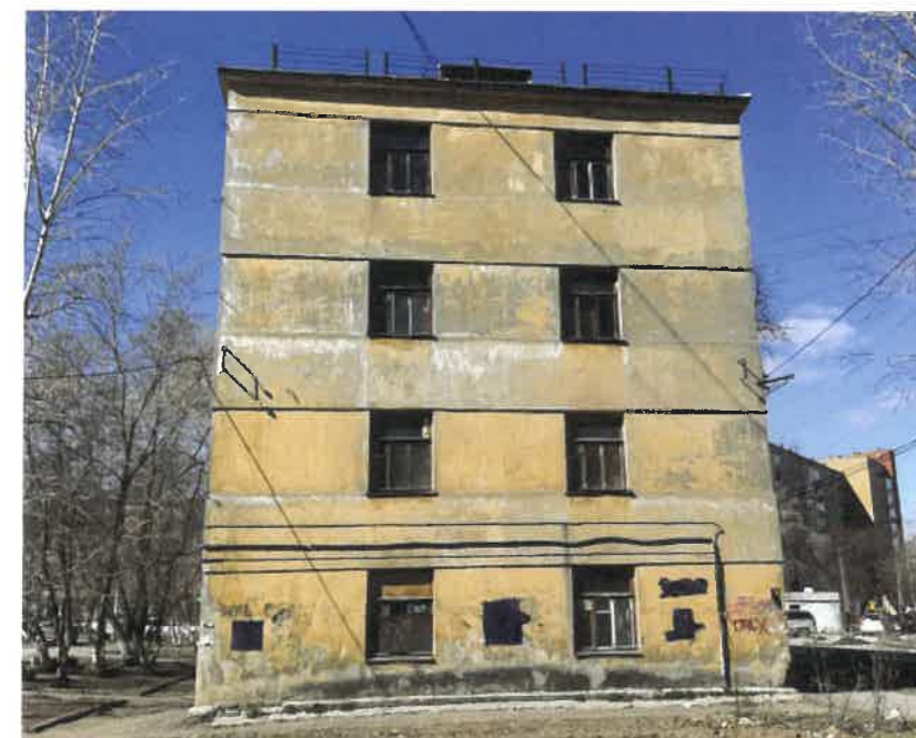
Существующее состояние бокового фасада (фотофиксация)
