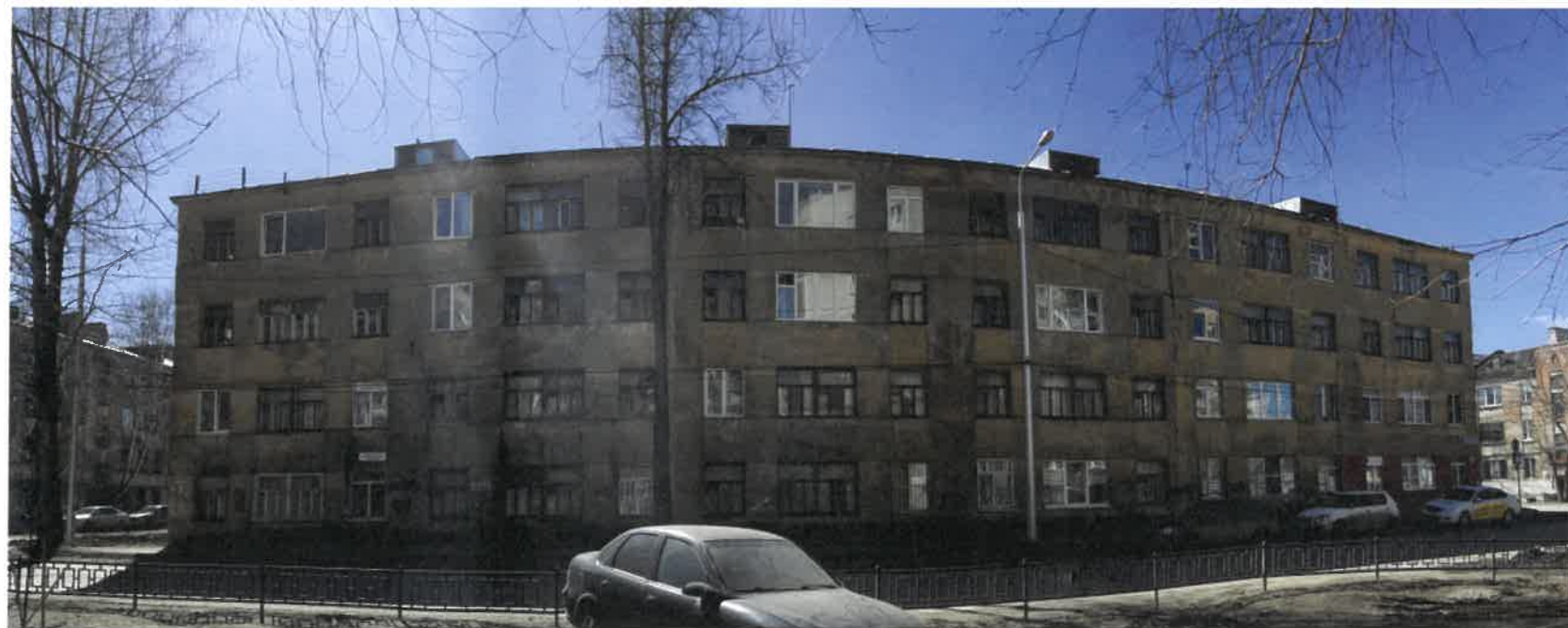
Существующее состояние главного фасада (фотофиксация)
