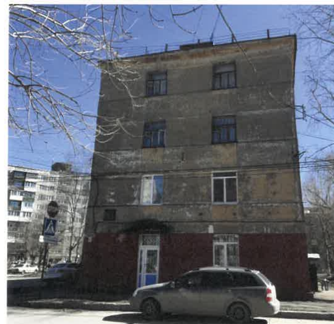
Существующее состояние бокового фасада (фотофиксация)
