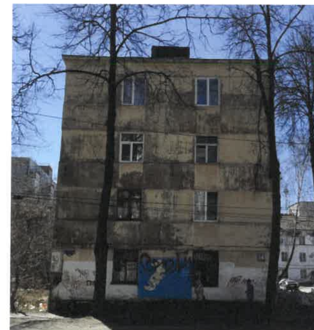
Существующее состояние бокового фасада (фотофиксация)
