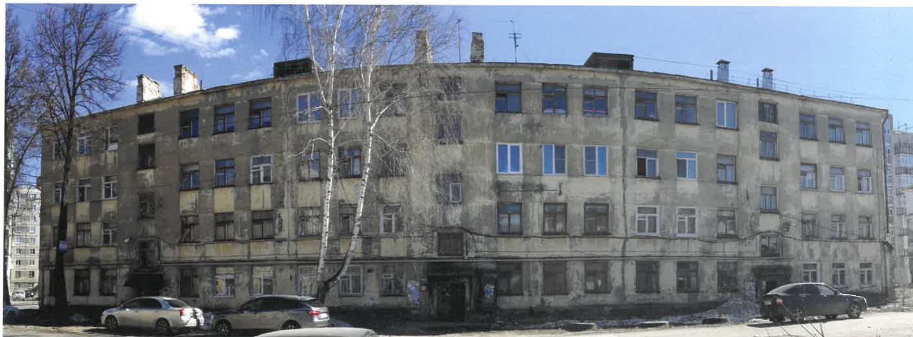
Существующее состояние дворового фасада (фотофиксация)
