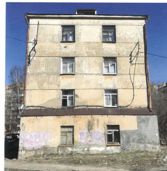
Существующее состояние бокового фасада (фотофиксация)
