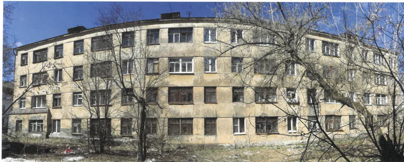
Существующее состояние главного фасада (фотофиксация)
