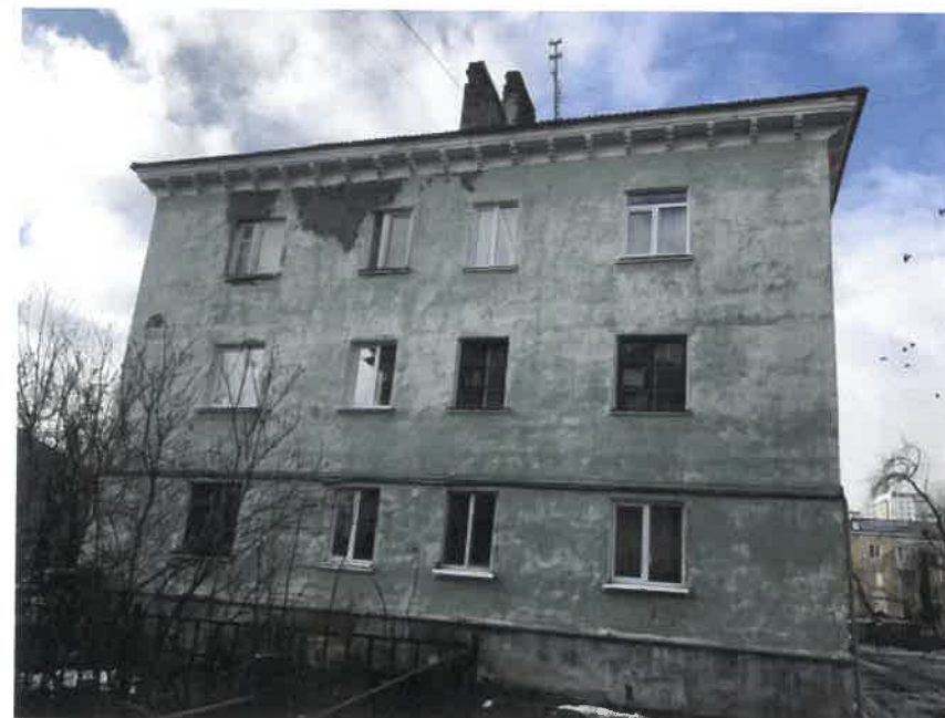
Существующее состояние бокового фасада (фотофиксация)
