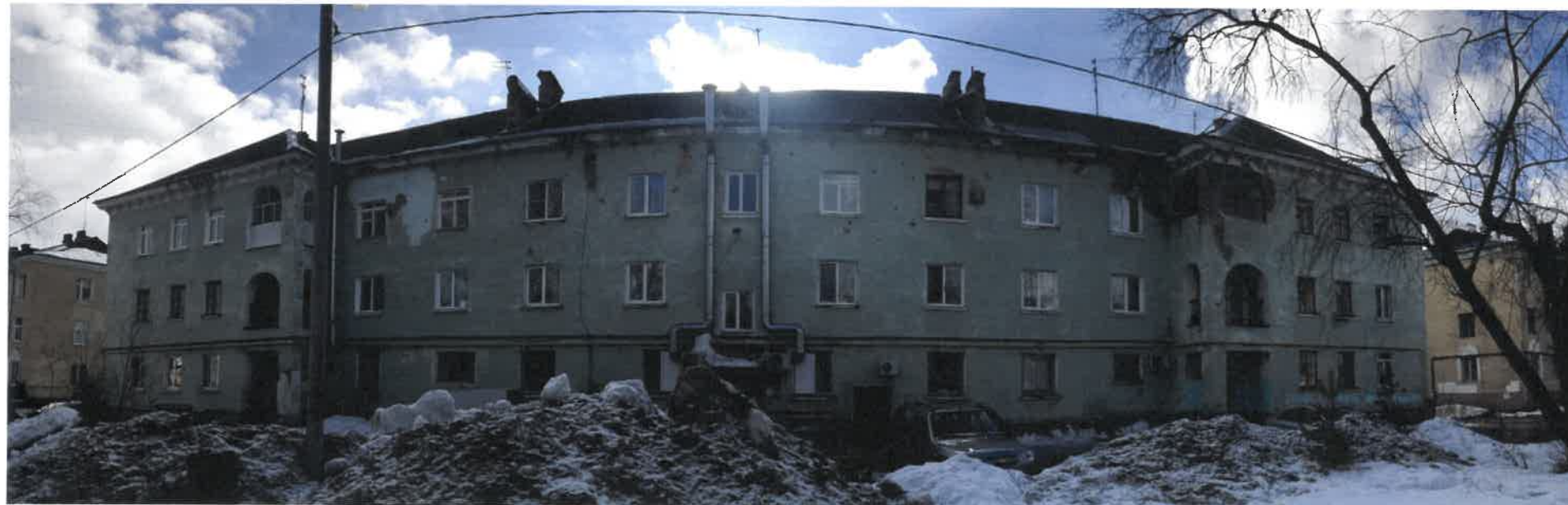
Существующее состояние дворового фасада (фотофиксация)
