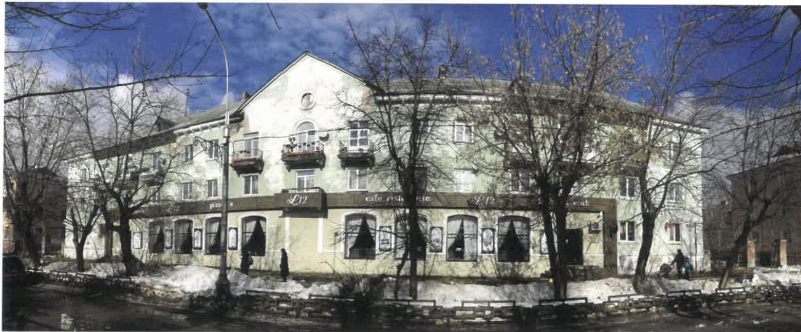
Существующее состояние главного фасада (фотофиксация)
