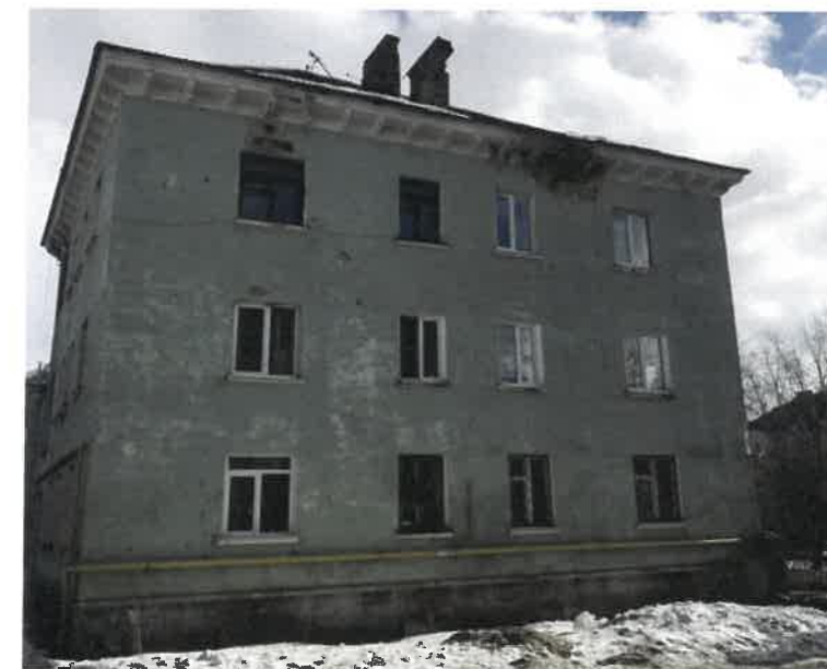
Существующее состояние бокового фасада (фотофиксация)
