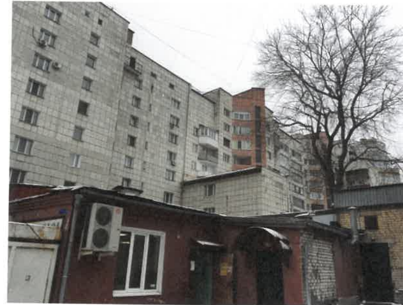
Существующее состояние дворового фасада (фотофиксация)
