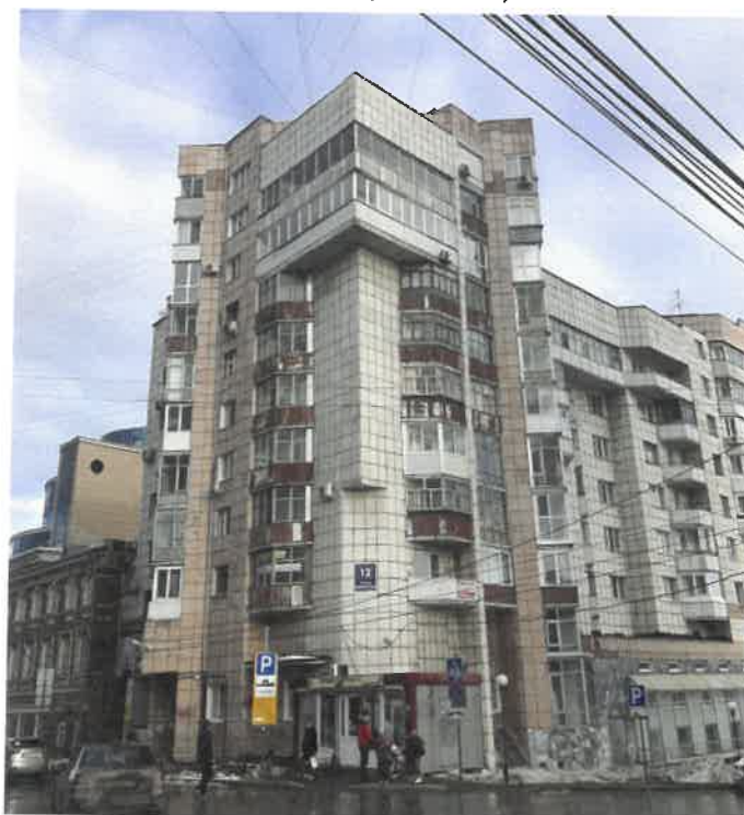
Существующее состояние бокового фасада (фотофиксация)
