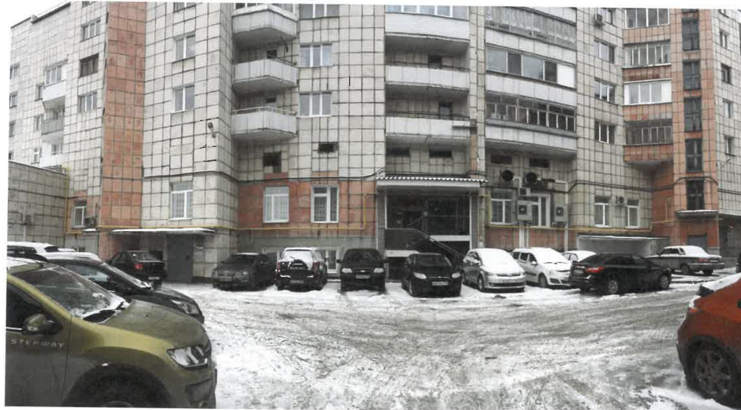
Существующее состояние дворового фасада (фотофиксация)
