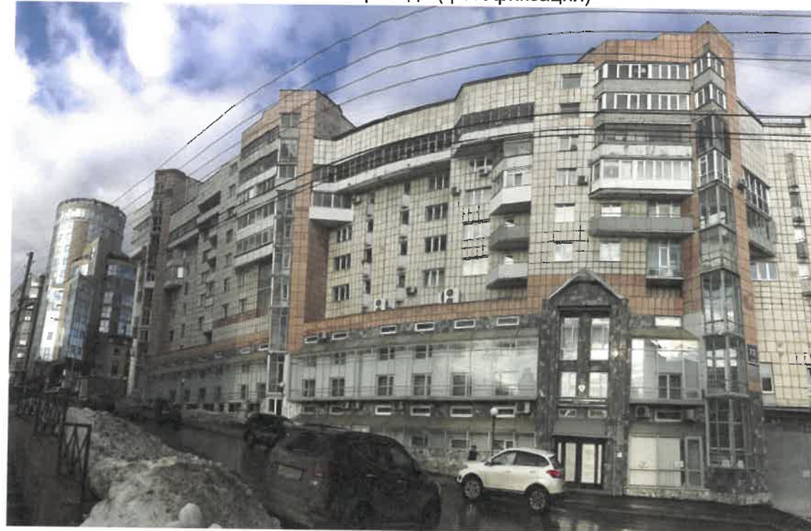
Существующее состояние главного фасада (фотофиксация)
