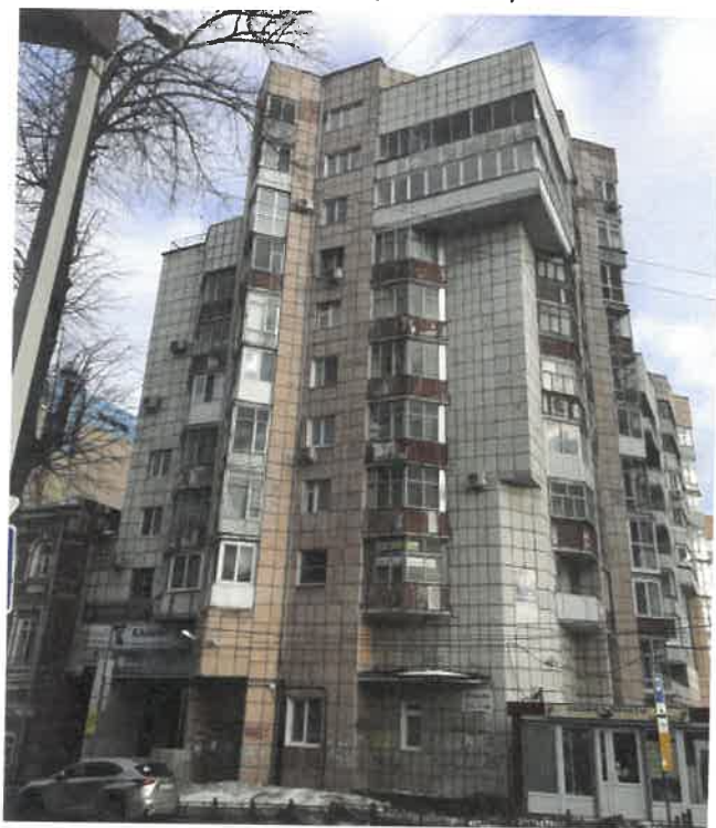
Существующее состояние бокового фасада (фотофиксация)
