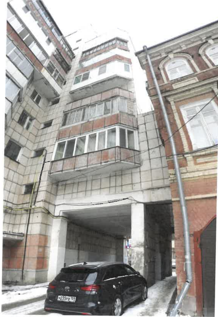
Существующее состояние дворового фасада (фотофиксация)
