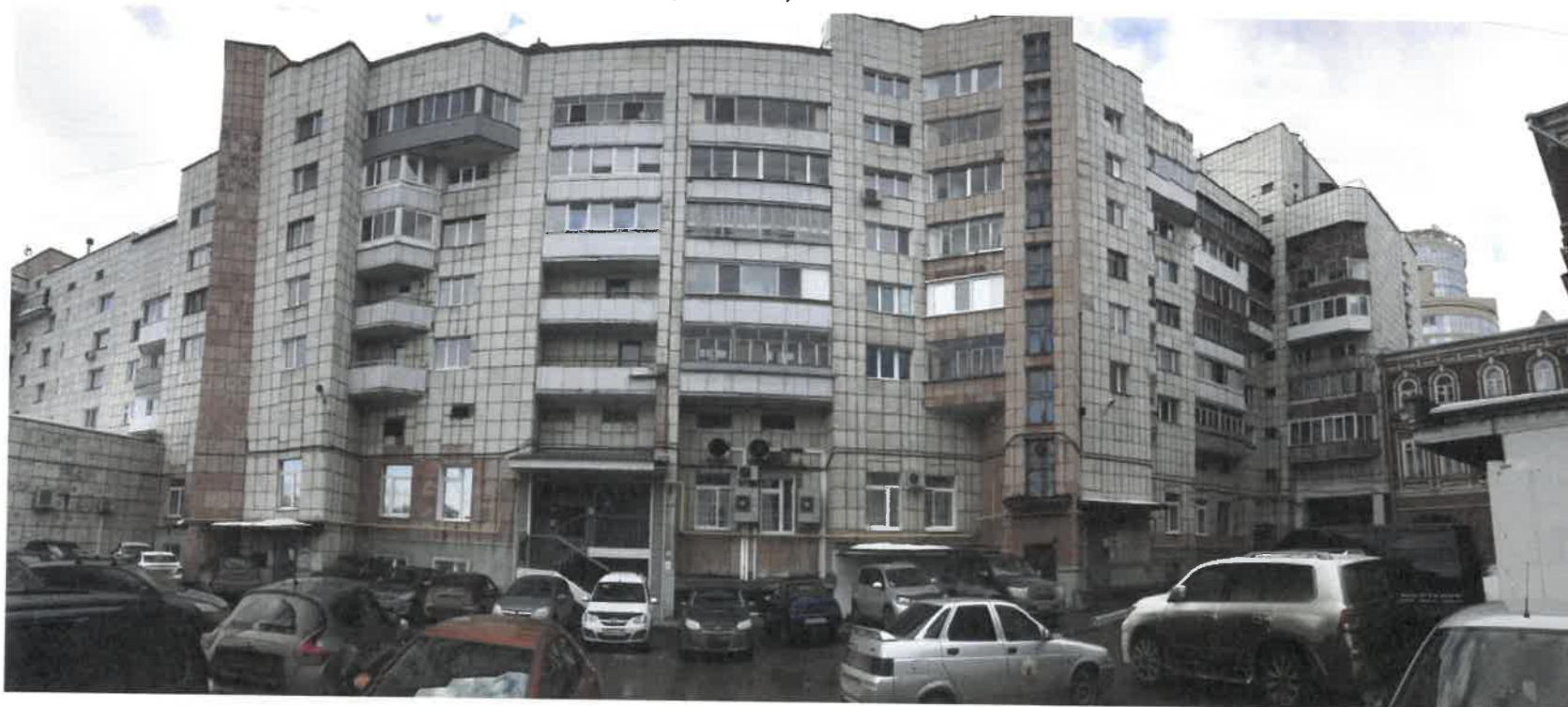
Существующее состояние дворового фасада (фотофиксация)
