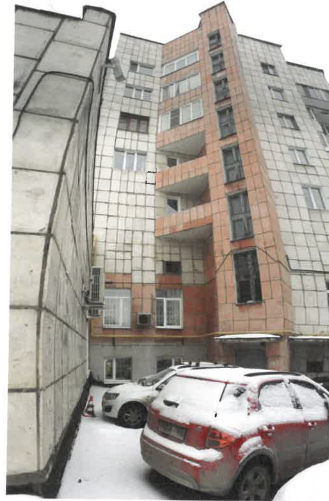
Существующее состояние дворового фасада (фотофиксация)
