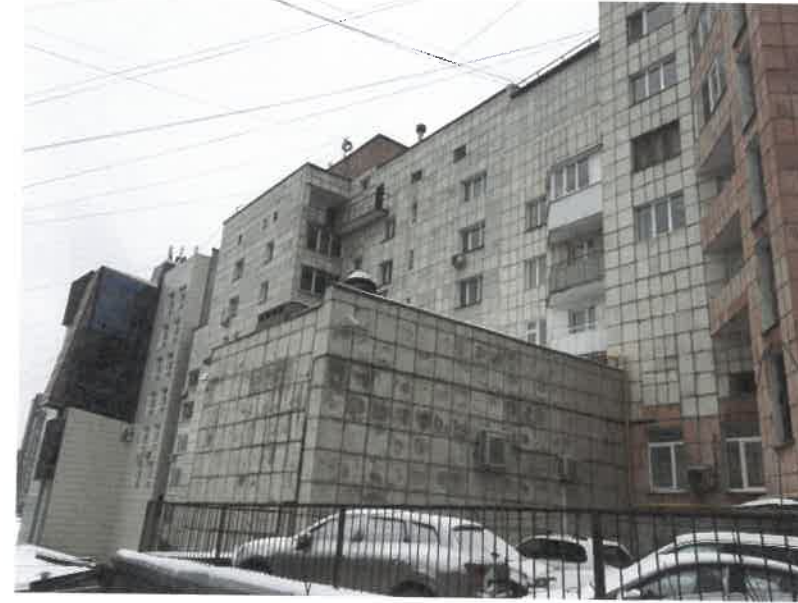
Существующее состояние дворового фасада (фотофиксация)
