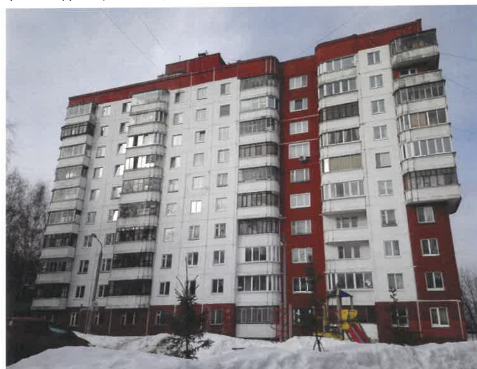
Существующее состояние бокового фасада (фотофиксация)
