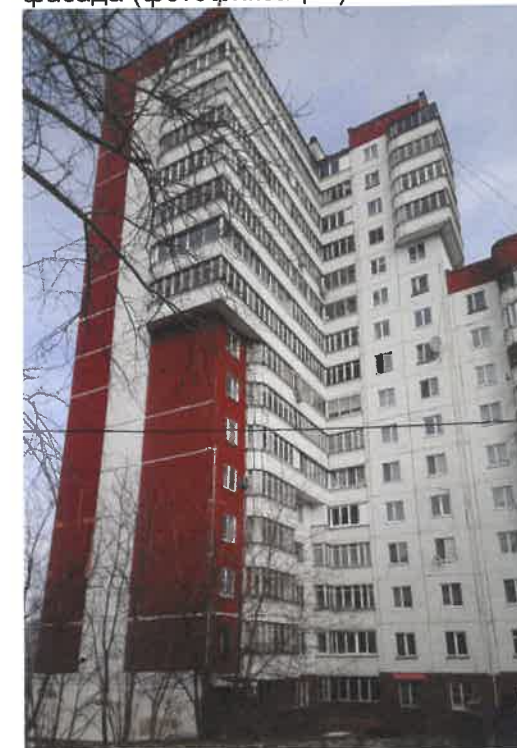
Существующее состояние главного фасада (фотофиксация)
