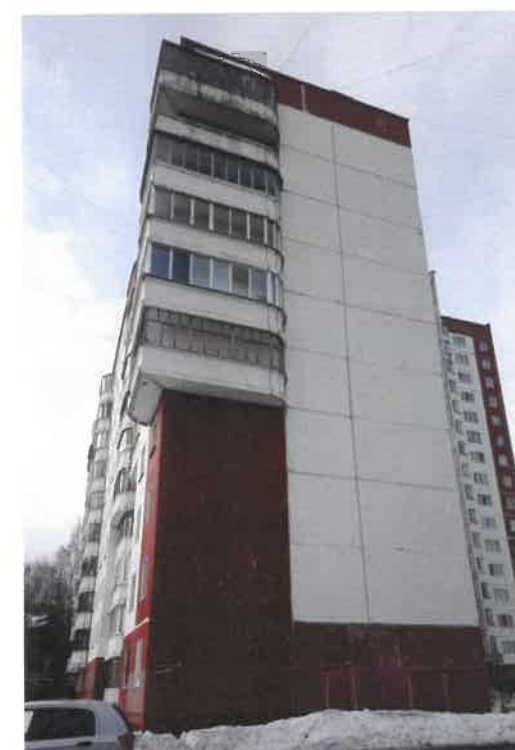
Существующее состояние бокового фасада (фотофиксация)
