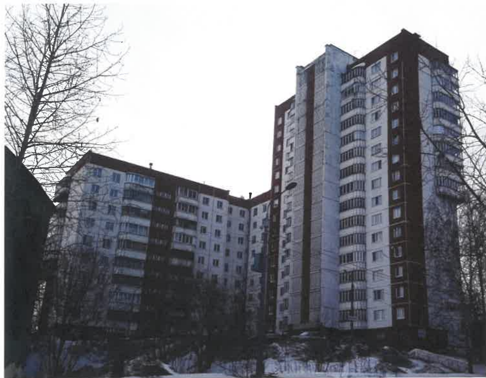
Существующее состояние дворового фасада (фотофиксация)
