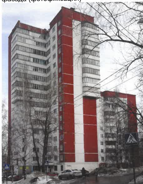
Существующее состояние главного фасада (фотофиксация)
