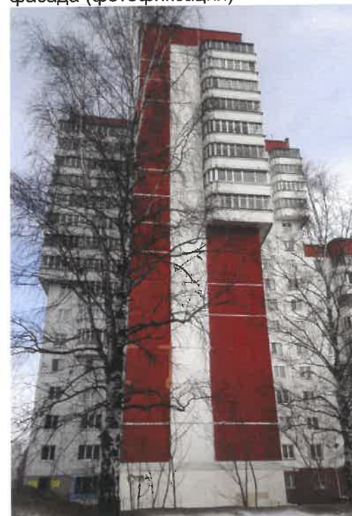
Существующее состояние главного фасада (фотофиксация)
