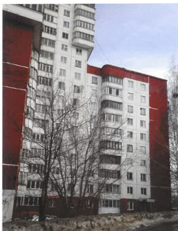
Существующее состояние главного фасада (фотофиксация)
