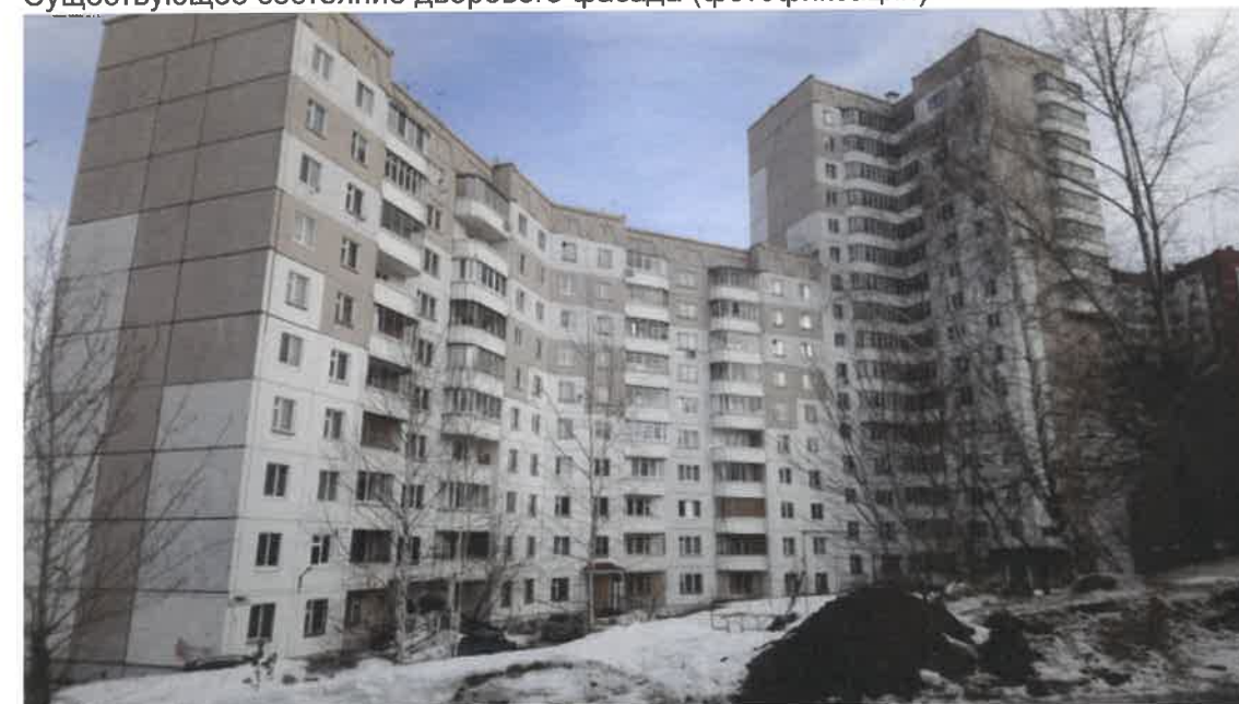
Существующее состояние дворового фасада (фотофиксация)
