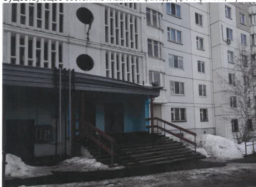
Существующее состояние главного фасада (фотофиксация)
