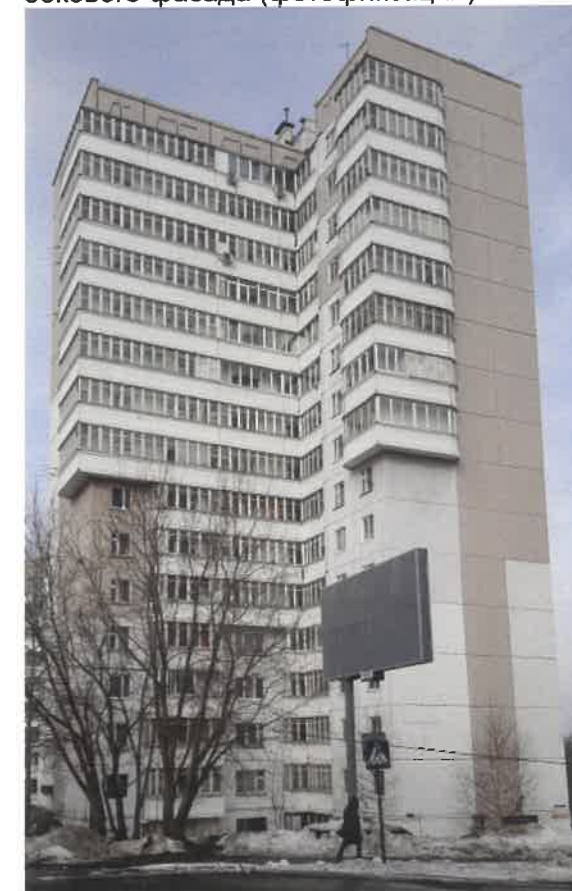
Существующее состояние бокового фасада (фотофиксация)
