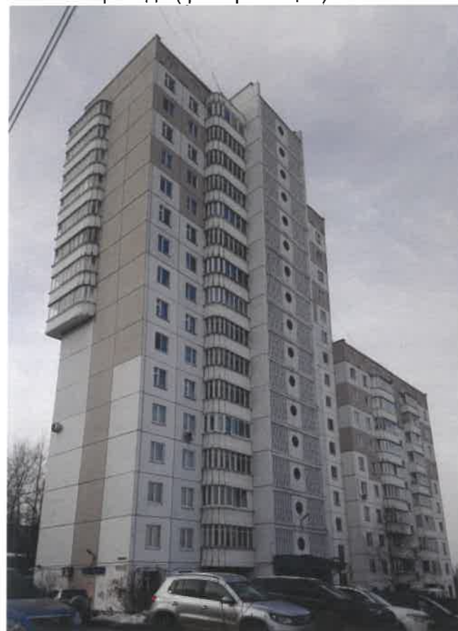
Существующее состояние главного фасада (фотофиксация)
