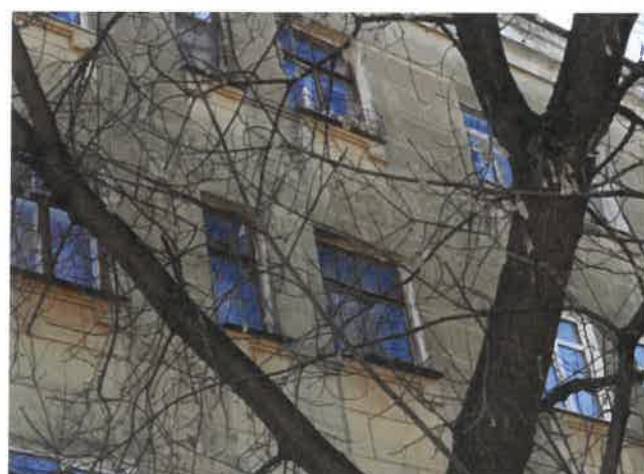
Существующее состояние главного фасада (фотофиксация)
