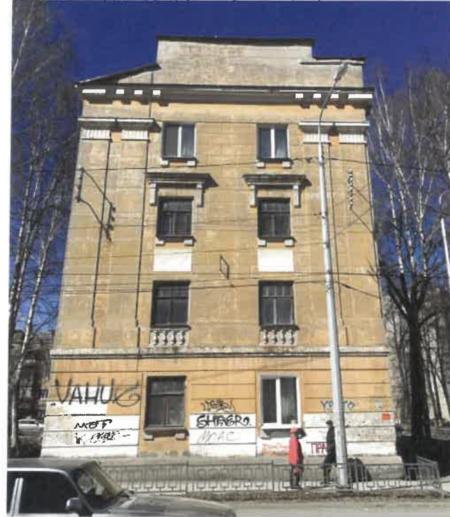
Существующее состояние бокового фасада (фотофиксация)
