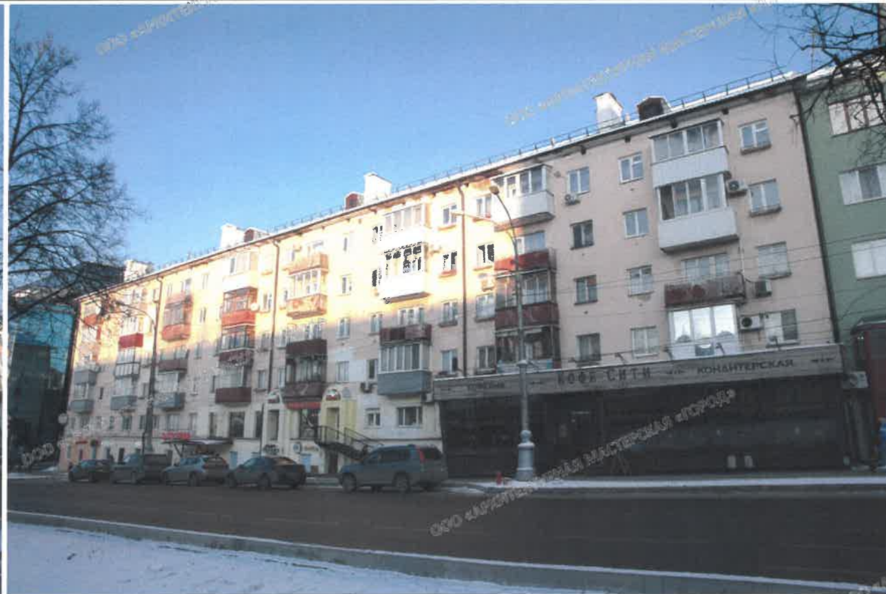
Главный фасад по проспекту Комсомольскому в осях 1-2
