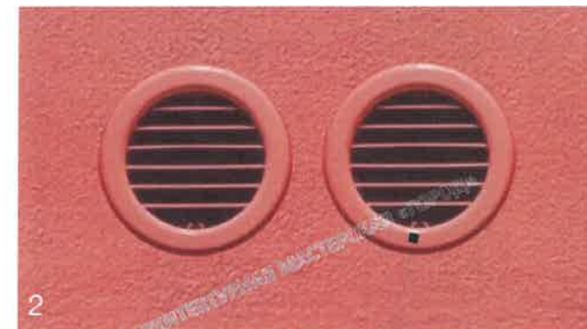
Наружу выводятся два гофрированных шланга с декоративными решетками
