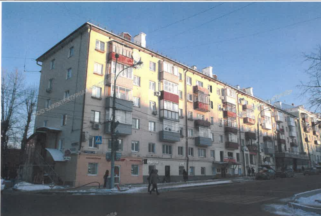
Главный фасад по проспекту Комсомольскому в осях 1-2
