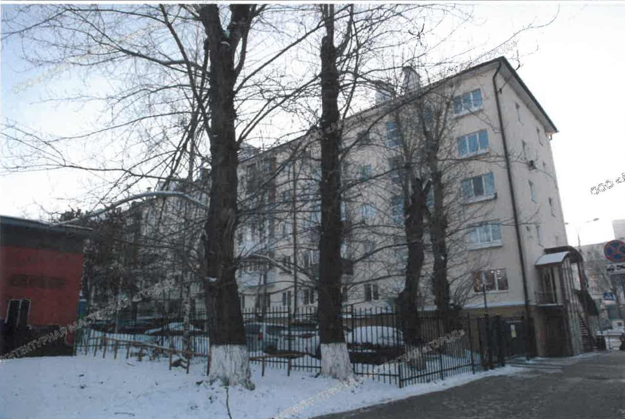
Дворовой фасад в осях 2-1
