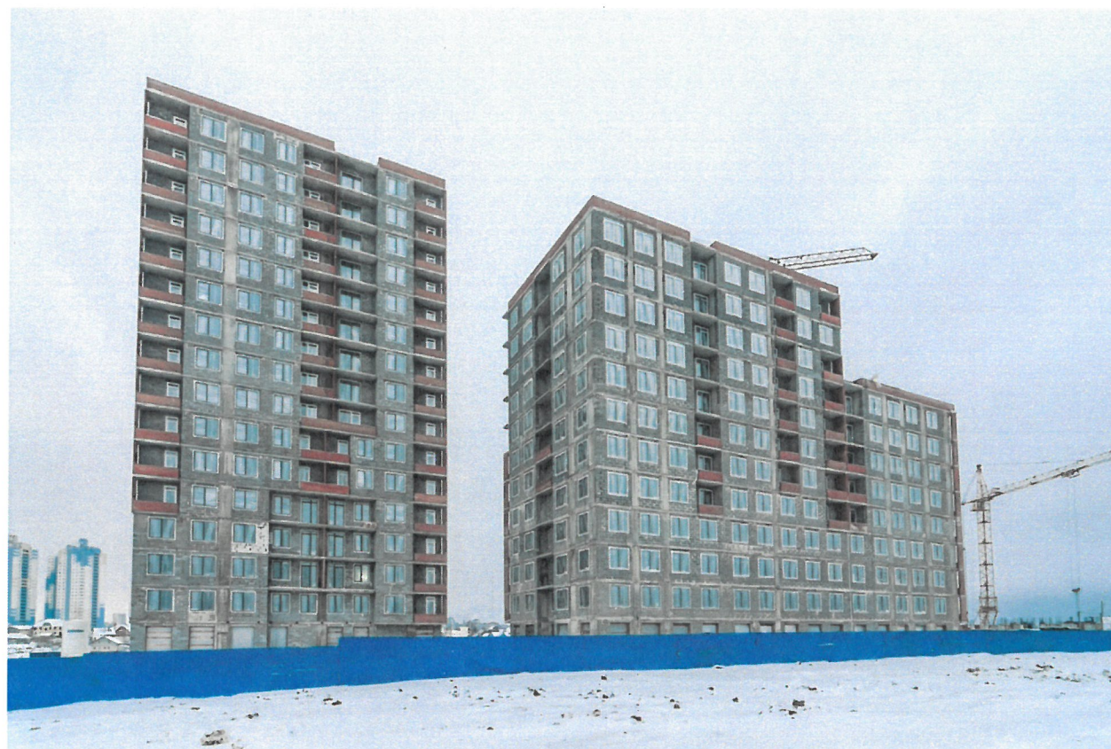
ГЛАВНЫЙ ФАСАД (В ОСЯХ 3-1)
