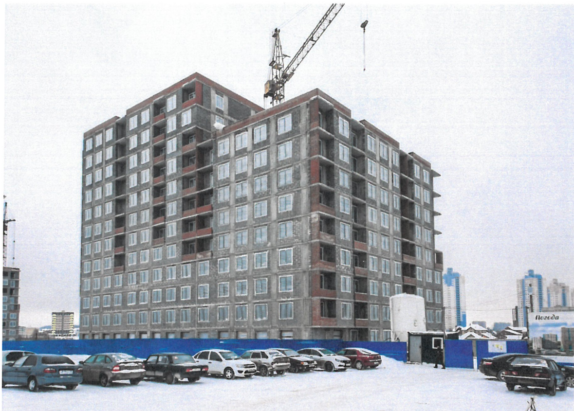
ГЛАВНЫЙ ФАСАД (В ОСЯХ 3-1)
