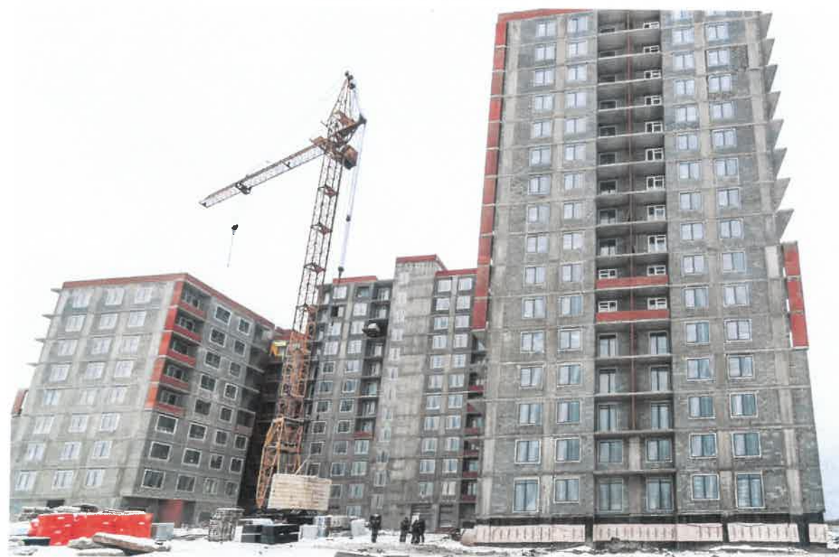
ДВОРОВОЙ ФАСАД (В ОСЯХ 3-4)
