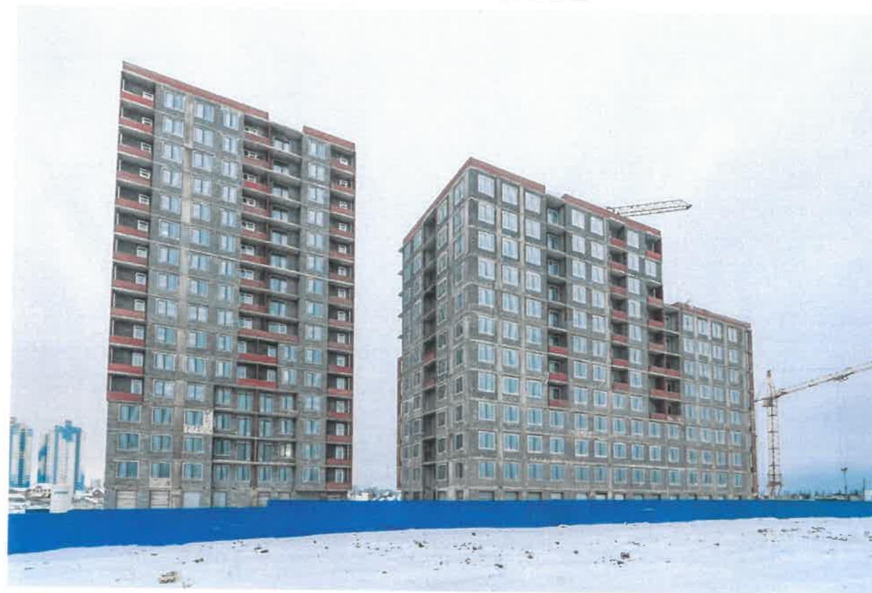
ГЛАВНЫЙ ФАСАД (В ОСЯХ 3-4)
