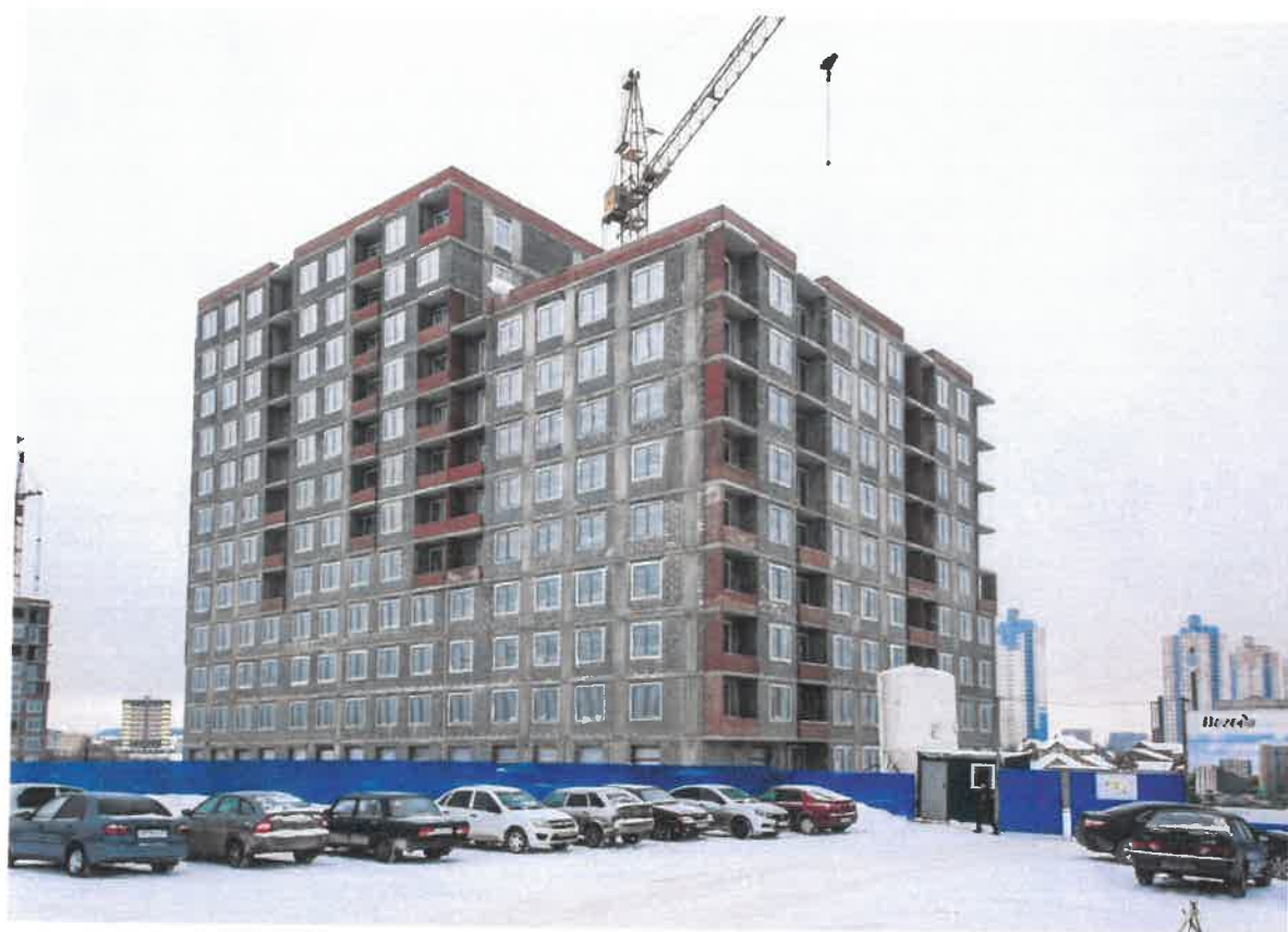
ГЛАВНЫЙ ФАСАД (В ОСЯХ 4-3)
