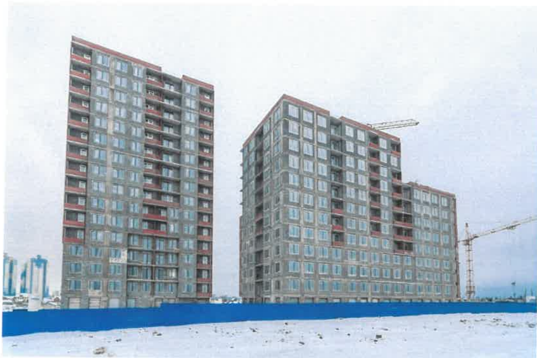
ГЛАВНЫЙ ФАСАД (В ОСЯХ 6-5)
