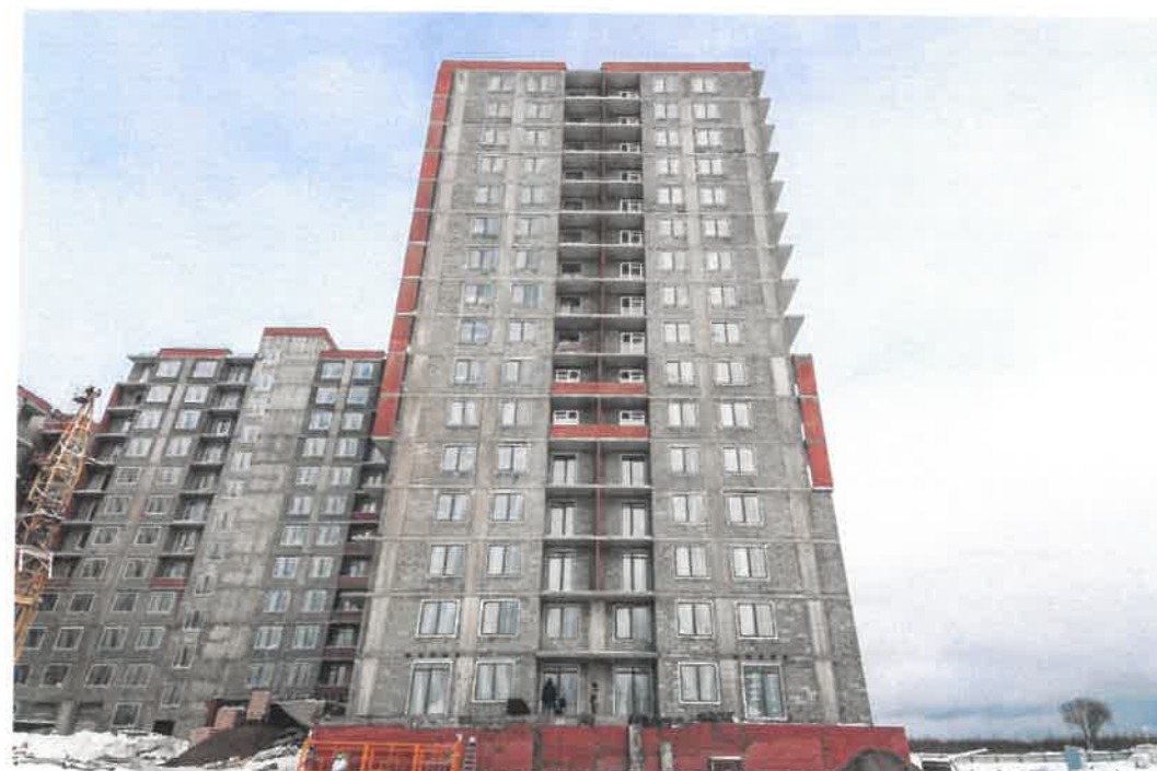
ДВОРОВОЙ ФАСАД (В ОСЯХ 5-6)
