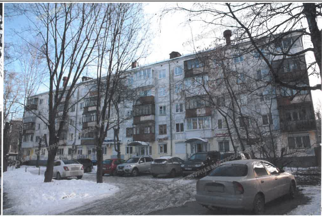
Главный фасад по ул. Тимирязева в осях 1-2
