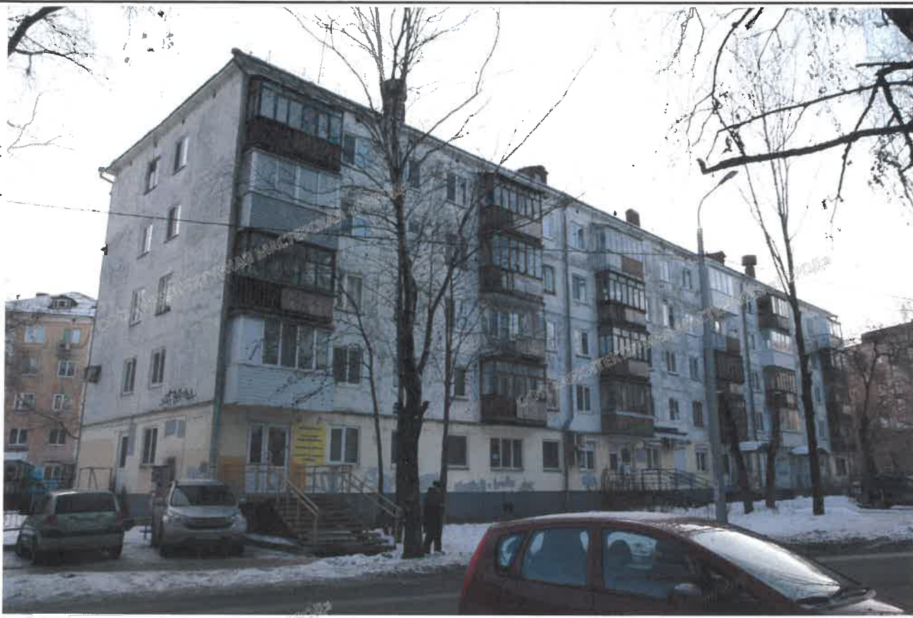
Главный фасад по пул. Тимирязева и боковой фасад в осях Б-А
