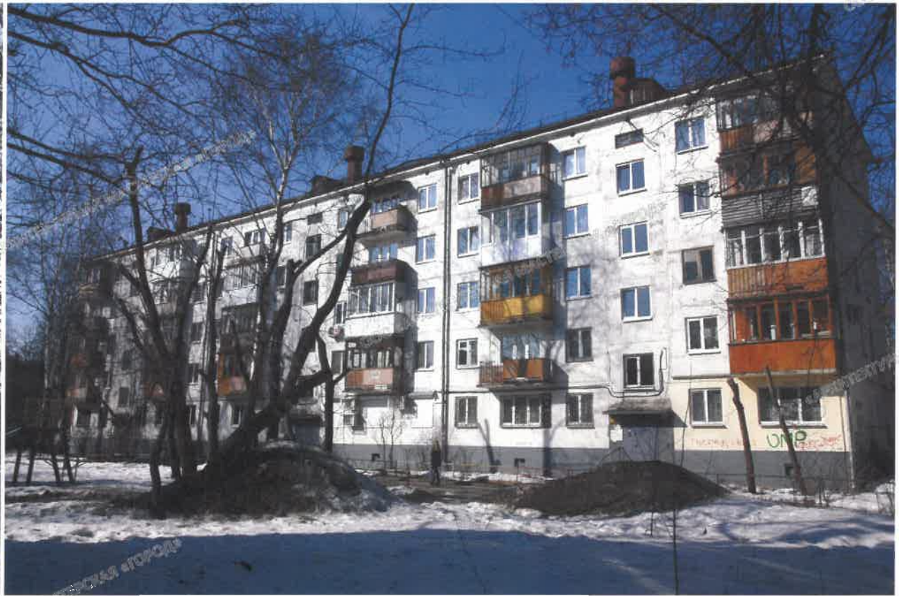
Дворовой фасад в осях 2-1
