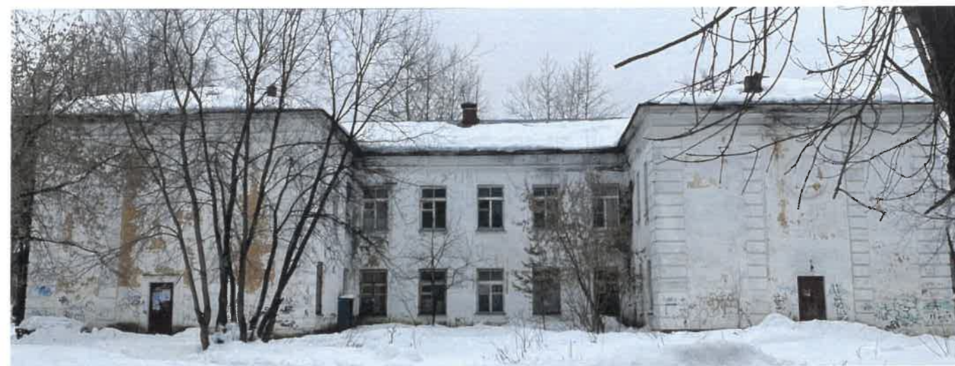
Существующее состояние дворового фасада
