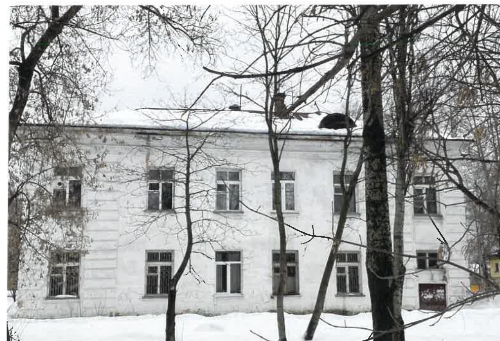
Существующее состояние бокового фасада
