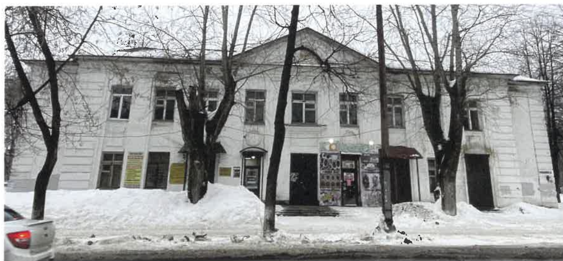
Существующее состояние главного фасада
