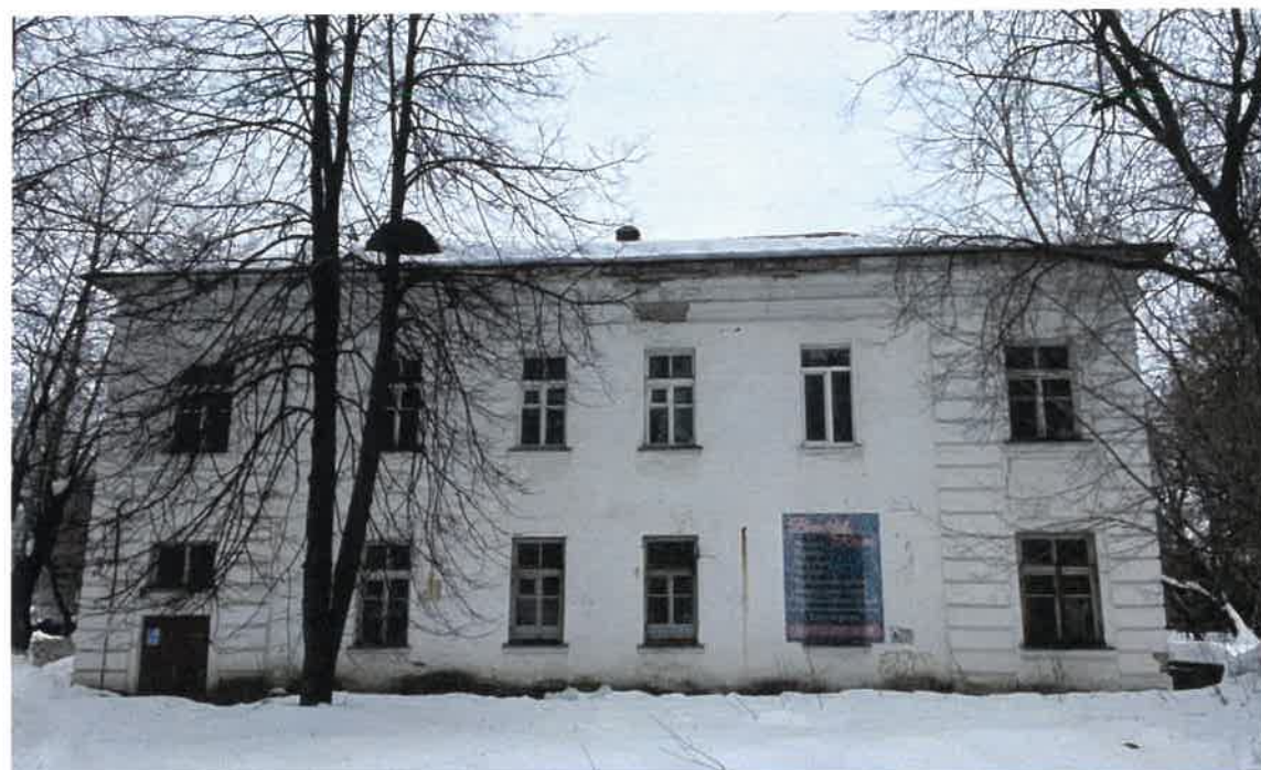
Существующее состояние бокового фасада
