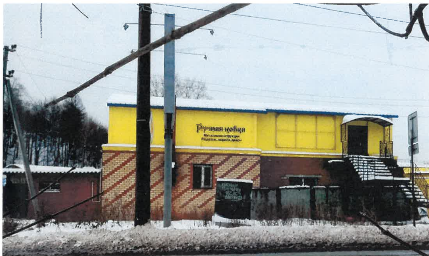
Существующее состояние главного фасада (фотофиксация).
