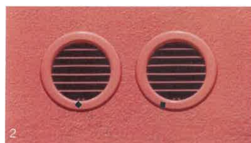
Наружу выводятся два гофрированных шланга с декоративными решетками
