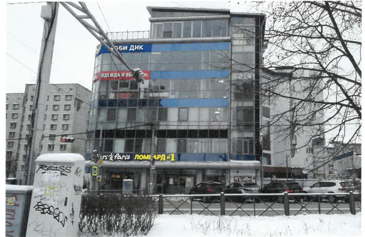
Фасад по ул. Попова
