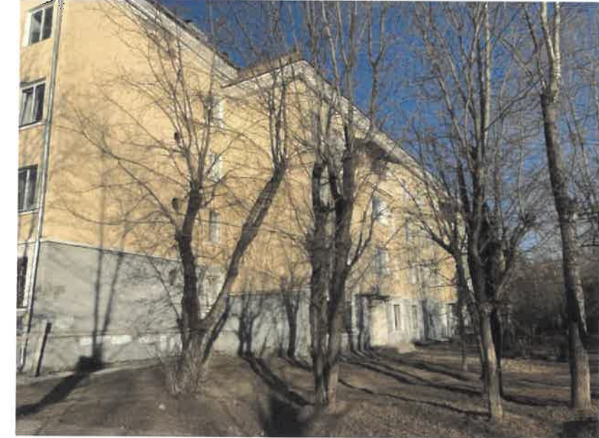
Существующее состояние бокового фасада со стороны улицы Чистопольская (фотофиксация)
