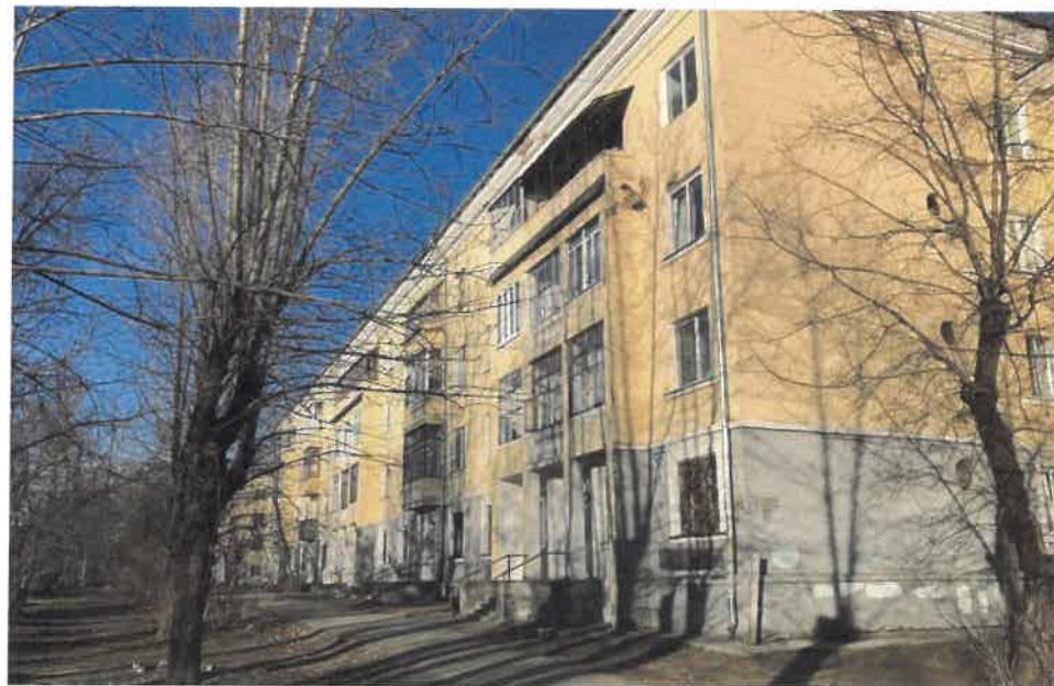
Существующее состояние главного фасада со стороны улицы Закамская (фотофиксация)
