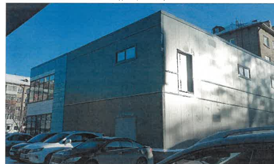
Существующее состояние бокового фасада (фотофиксация)
