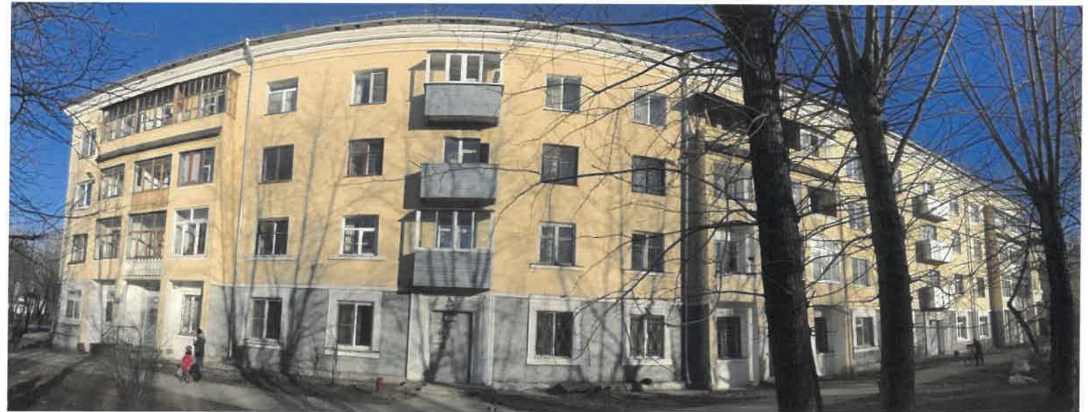
Существующее состояние дворового фасада со стороны ул. Кировоградская (фотофиксация)
