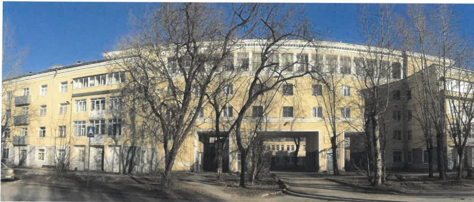
Существующее состояние главного фасада со стороны ул. Закамская (фотофиксация)
