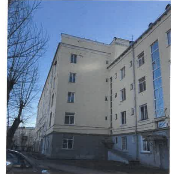
Существующее состояние дворового фасада со стороны ул. Кировоградская (фотофиксация)
