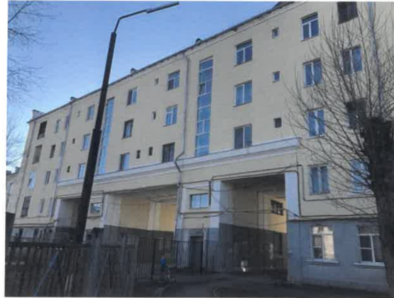
Существующее состояние дворового фасада со стороны ул. Кировоградская (фотофиксация)
