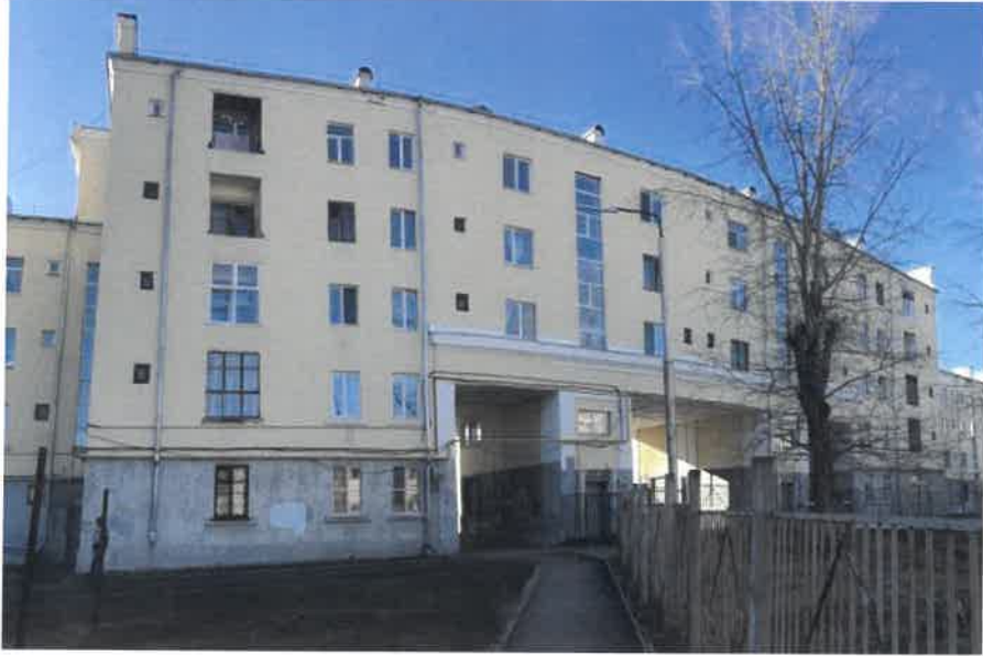
Существующее состояние дворового фасада со стороны ул. Кировоградская (фотофиксация)
