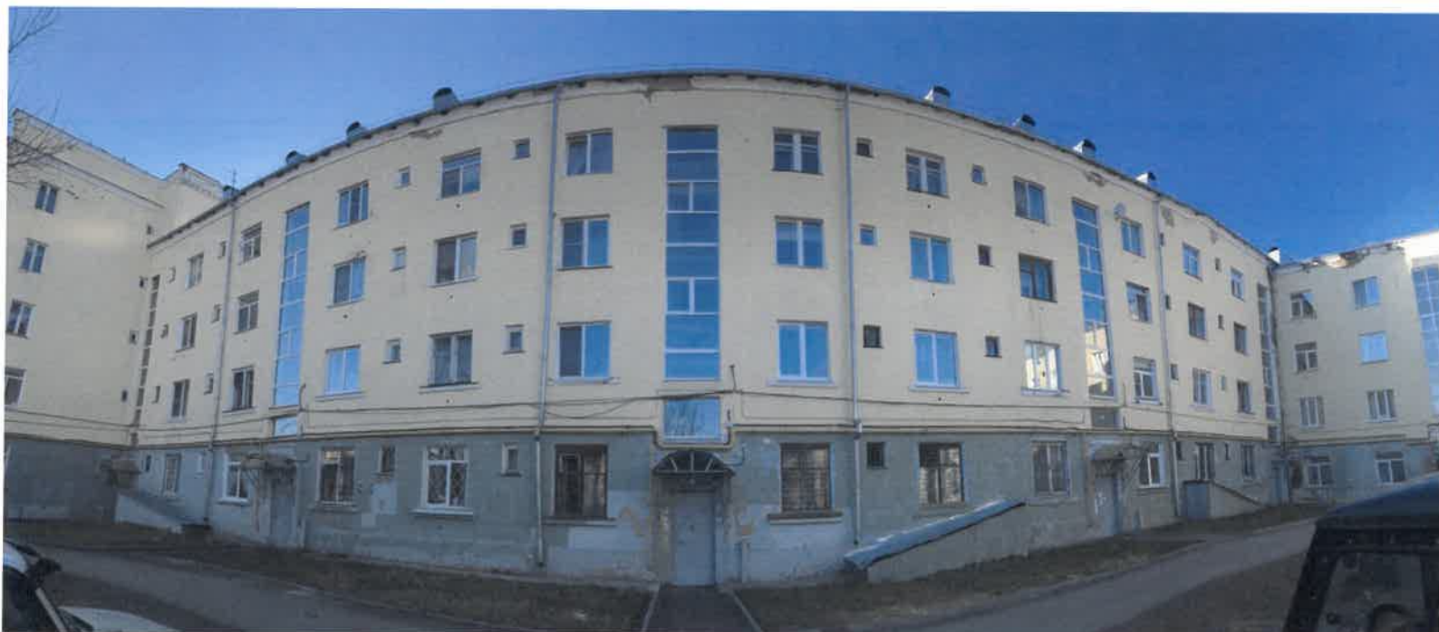
Существующее состояние дворового фасада со стороны ул. Кировоградская (фотофиксация)
