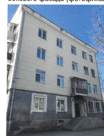
Существующее состояние бокового фасада (фотофиксация)
