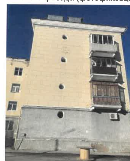
Существующее состояние бокового фасада (фотофиксация)
