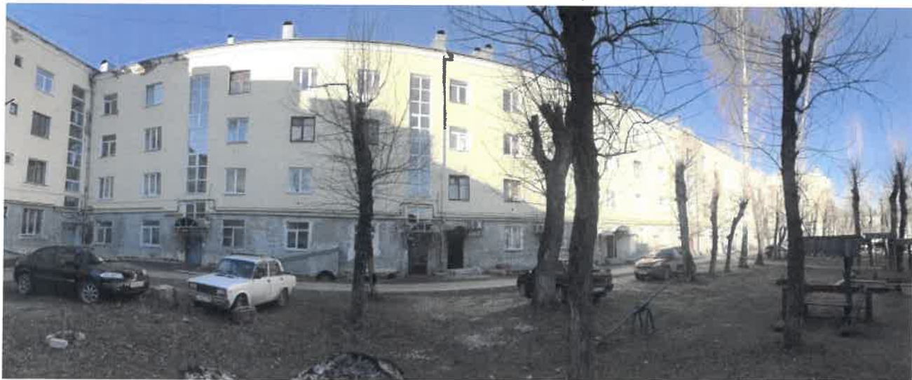
Существующее состояние дворового фасада (фотофиксация)
