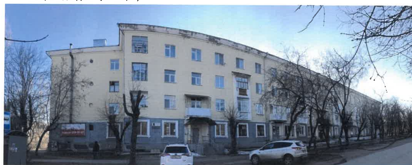
Существующее состояние главного фасада (фотофиксация)
