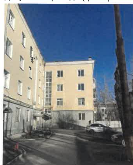
Существующее состояние дворового фасада (фотофиксация)
