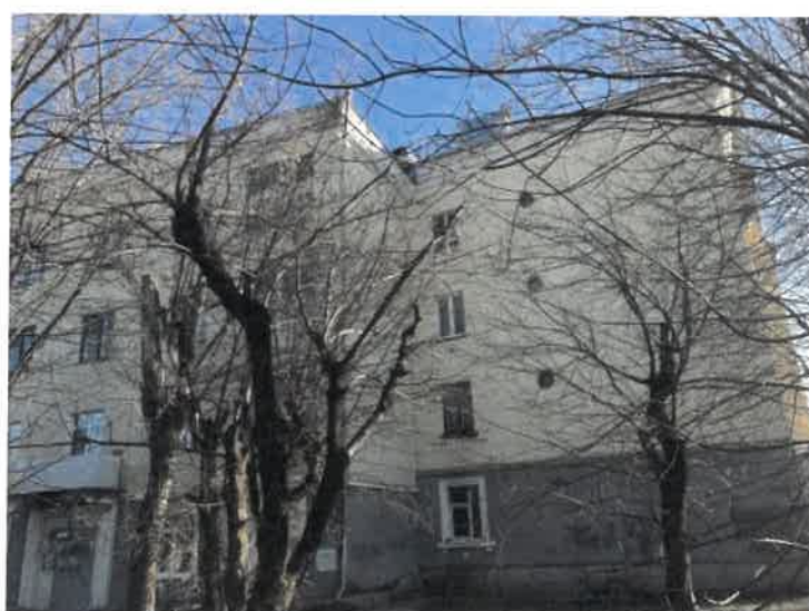
Существующее состояние главного фасада (фотофиксация)
