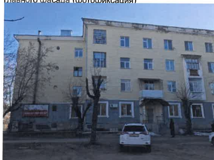
Существующее состояние главного фасада (фотофиксация)
