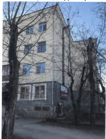
Существующее состояние бокового фасада (фотофиксация)
