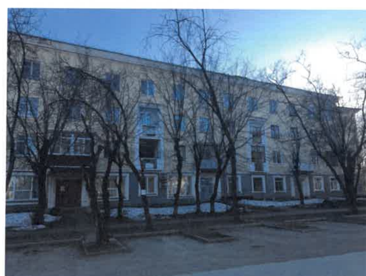
Существующее состояние главного фасада (фотофиксация)
