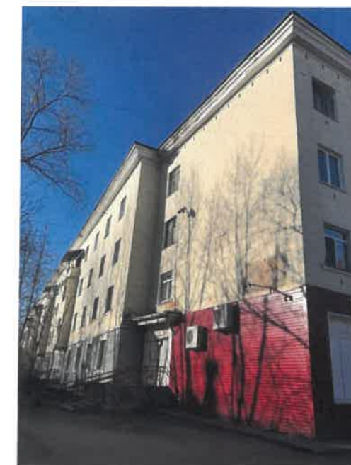
Существующее состояние главного фасада (фотофиксация)
