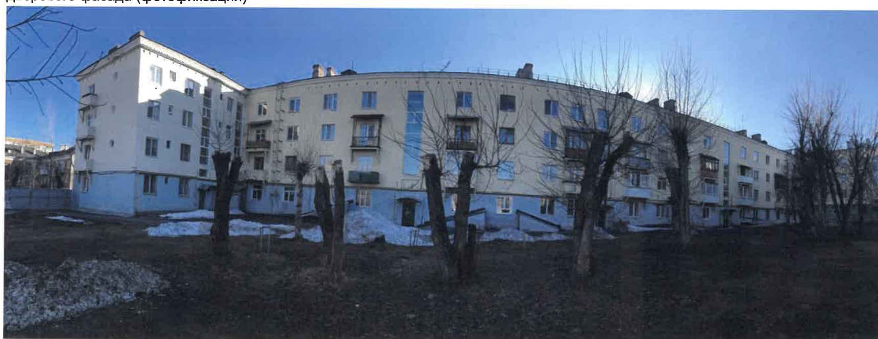
Существующее состояние дворового фасада (фотофиксация)
