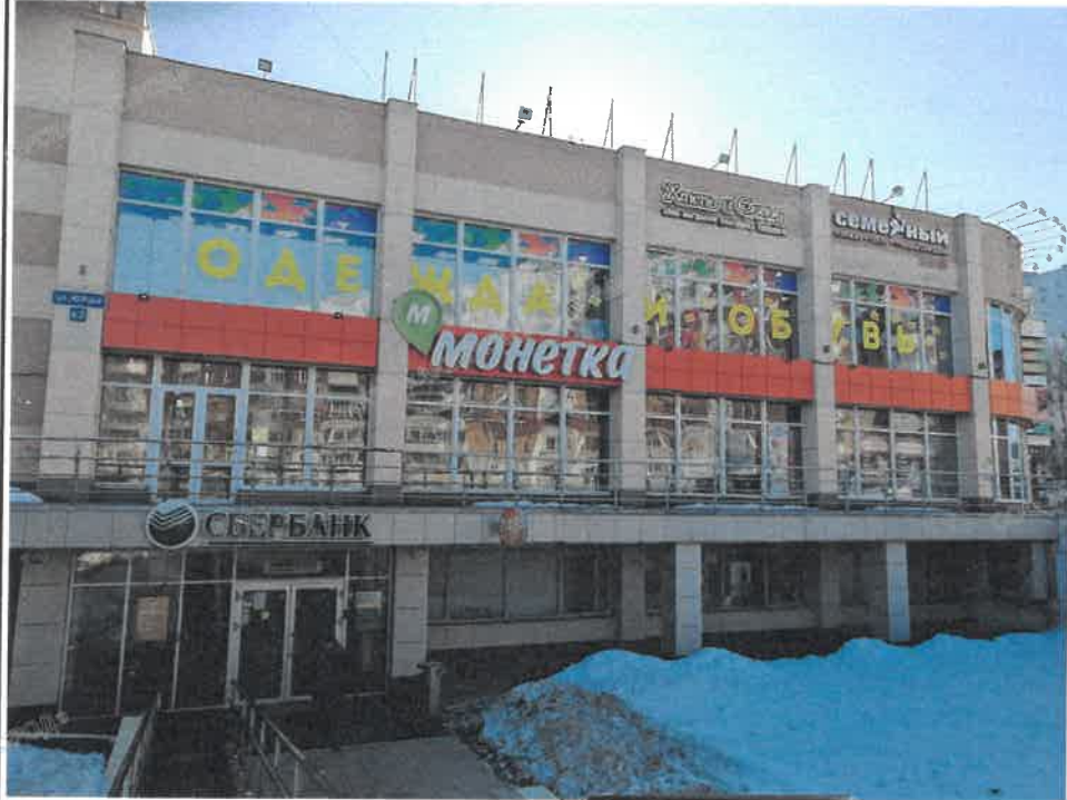
Фрагмент главного фасада по ул.Юрша в осях 1-2
