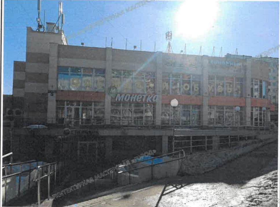
Главный фасад по ул.Юрша в осях 1-2
