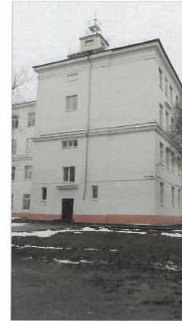
Дворовой фасад (место проектируемого пристраиваемого спортзала)
