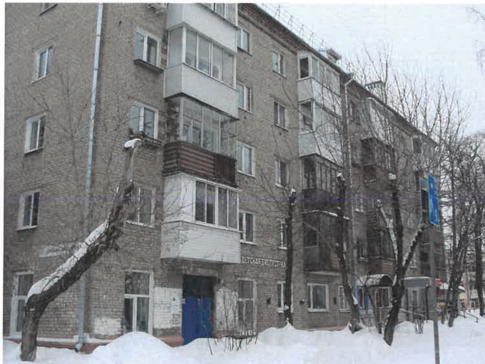
Существующее состояние главного фасада в осях 1-2
