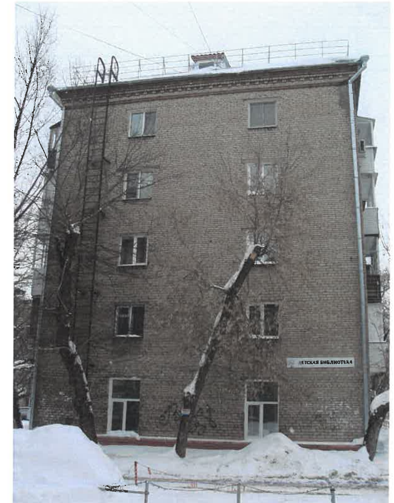
Существующее состояние торцевого фасада в осях Б-А
