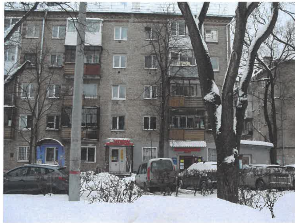
Существующее состояние главного фасада в осях 1-2
