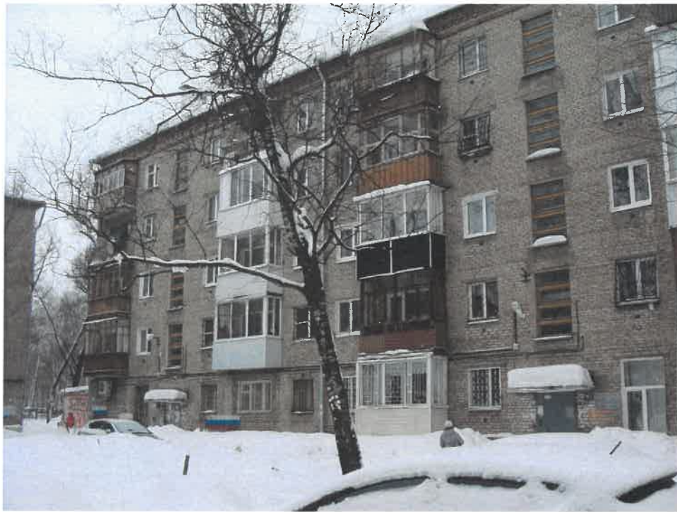
Существующее состояние дворового фасада в осях 2-1
