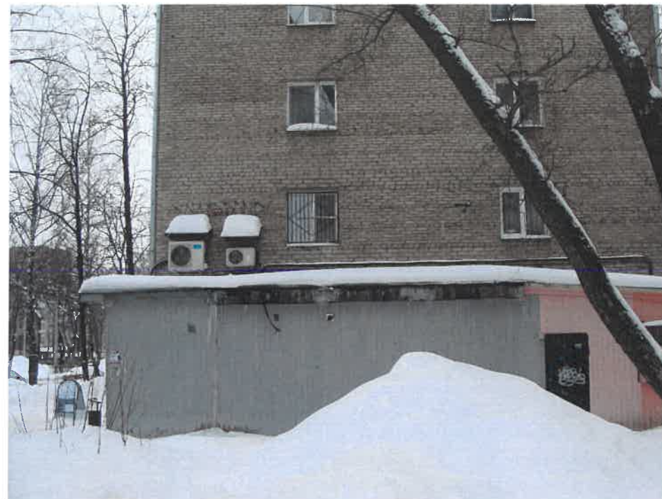
Существующее состояние торцевого фасада в осях А-Б
