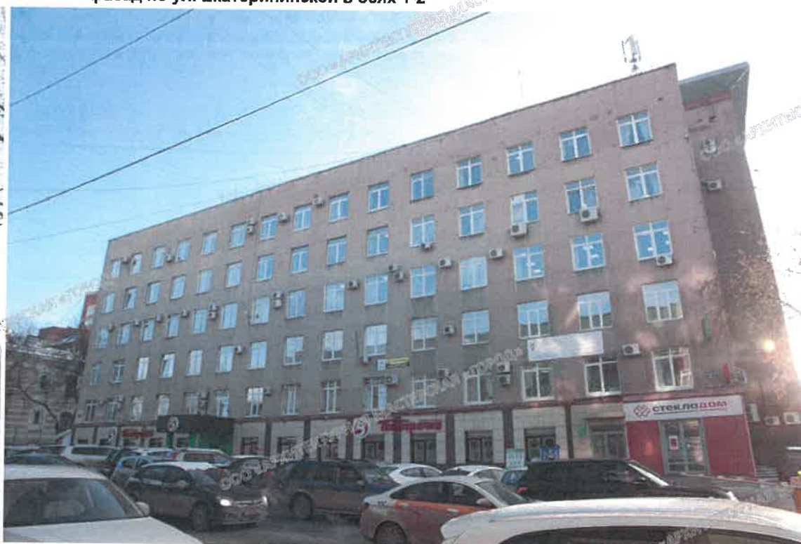
Главный фасад по ул. Екатерининской в осях 1-2
