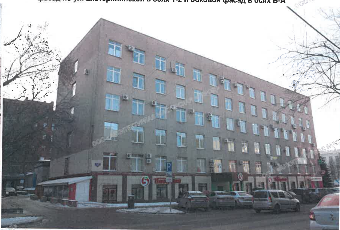
Главный фасад по ул. Екатерининской в осях 1-2 и боковой фасад в осях Б-А
