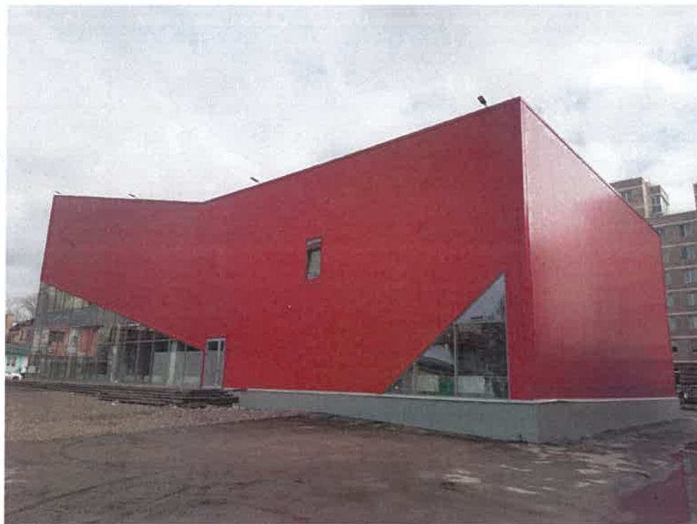
Существующее состояние главного фасада (фотофиксация)
