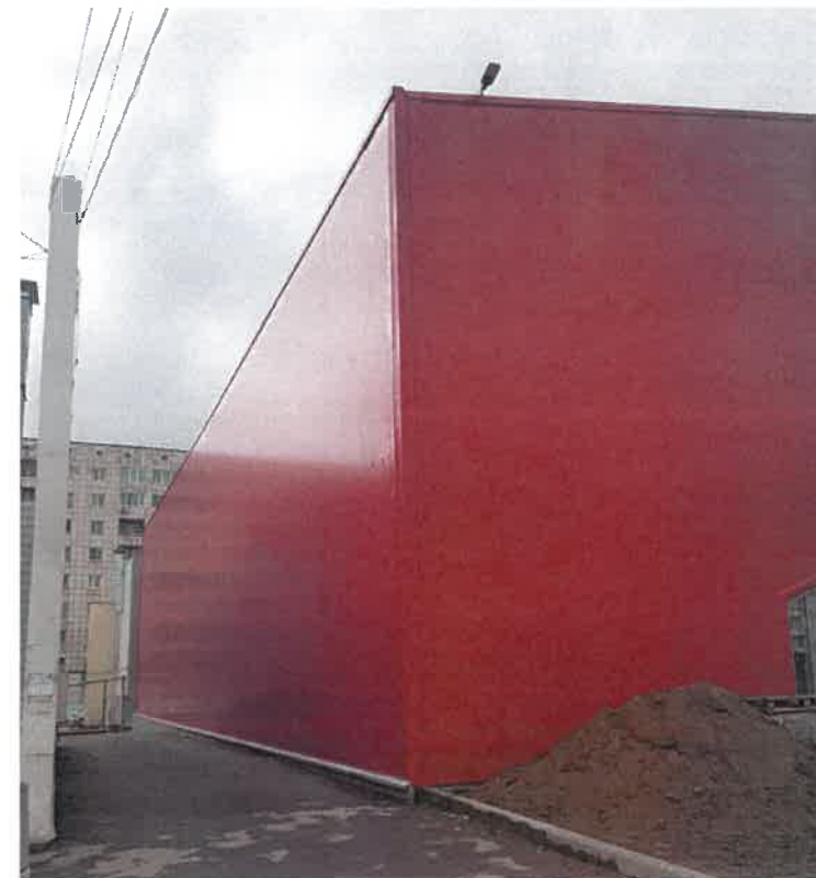
Существующее состояние дворового фасада (фотофиксация)
