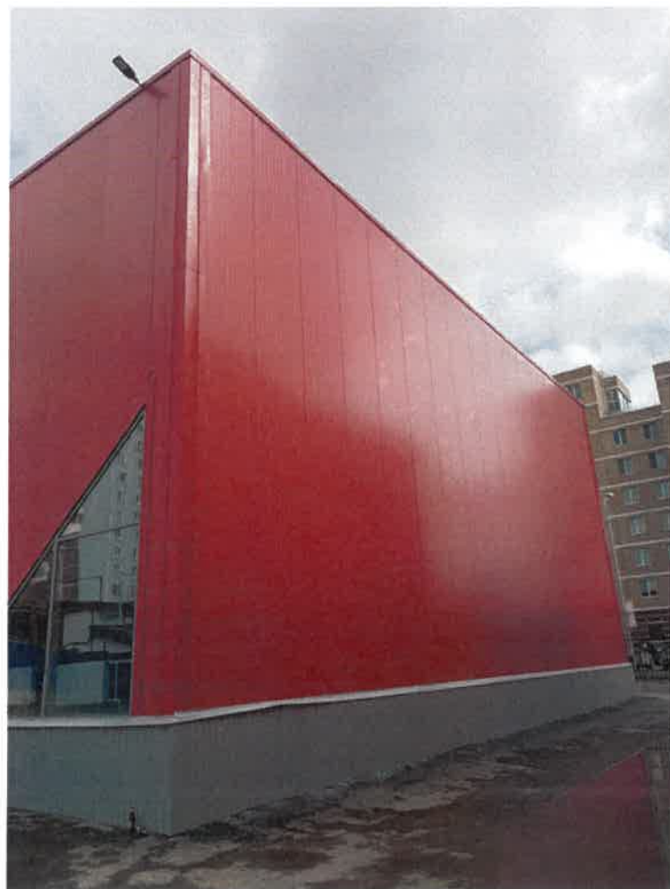
Существующее состояние бокового фасада (фотофиксация)
