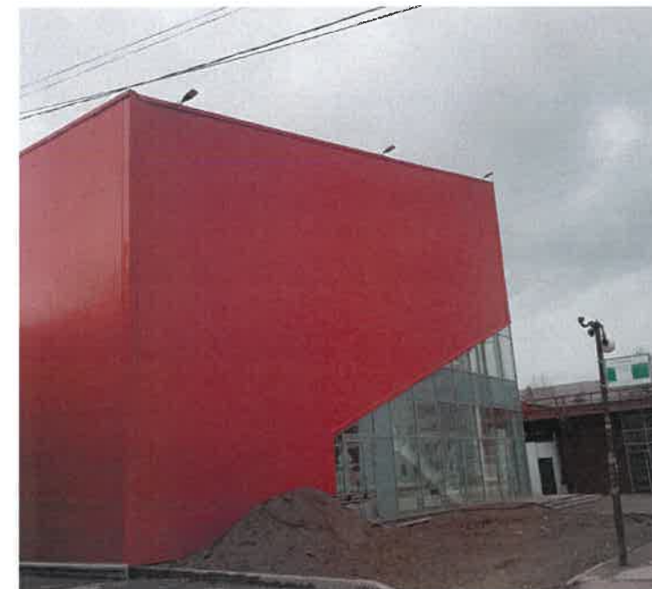
Существующее состояние бокового фасада (фотофиксация)
