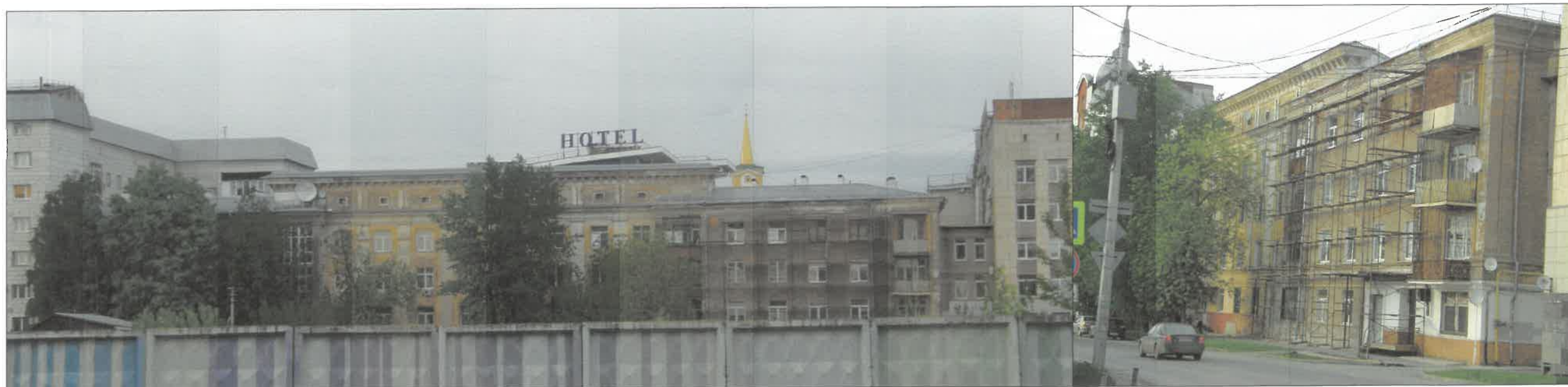
Существующее состояние главного (и бокового) фасада по ул. Осинская (в осях 1-5)
