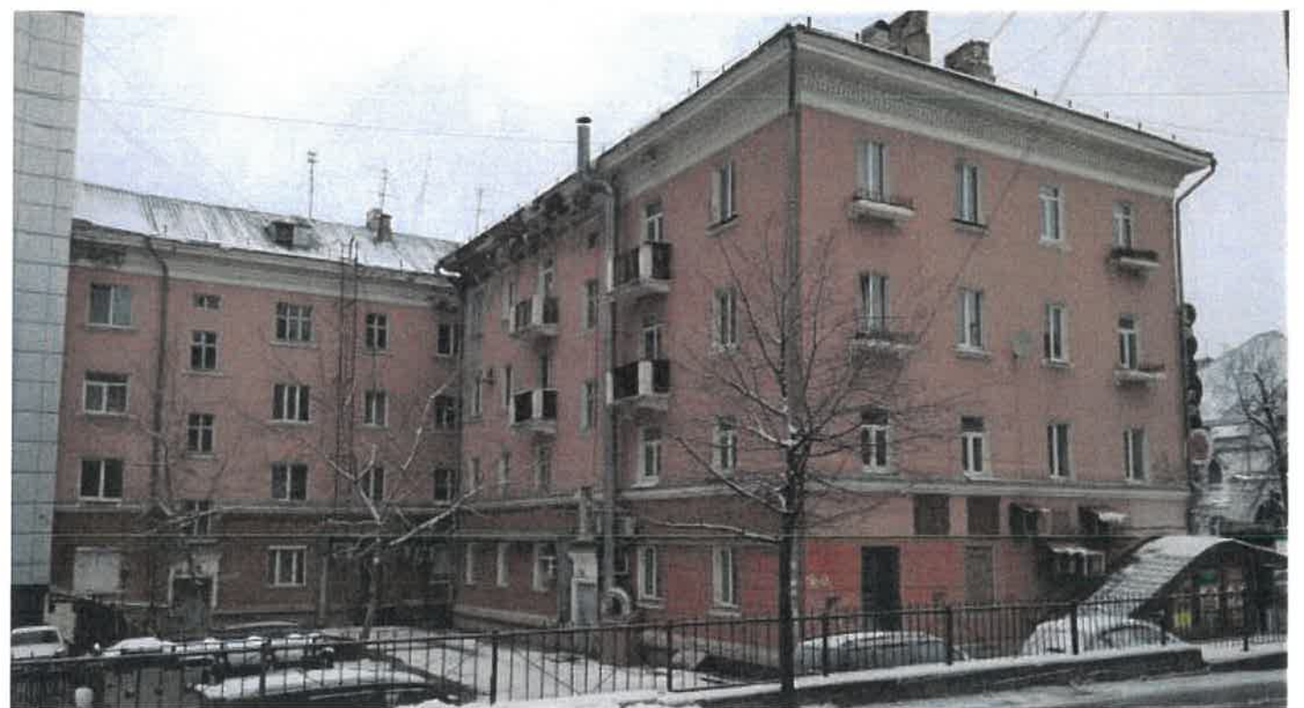
Существующее состояние дворового фасада
