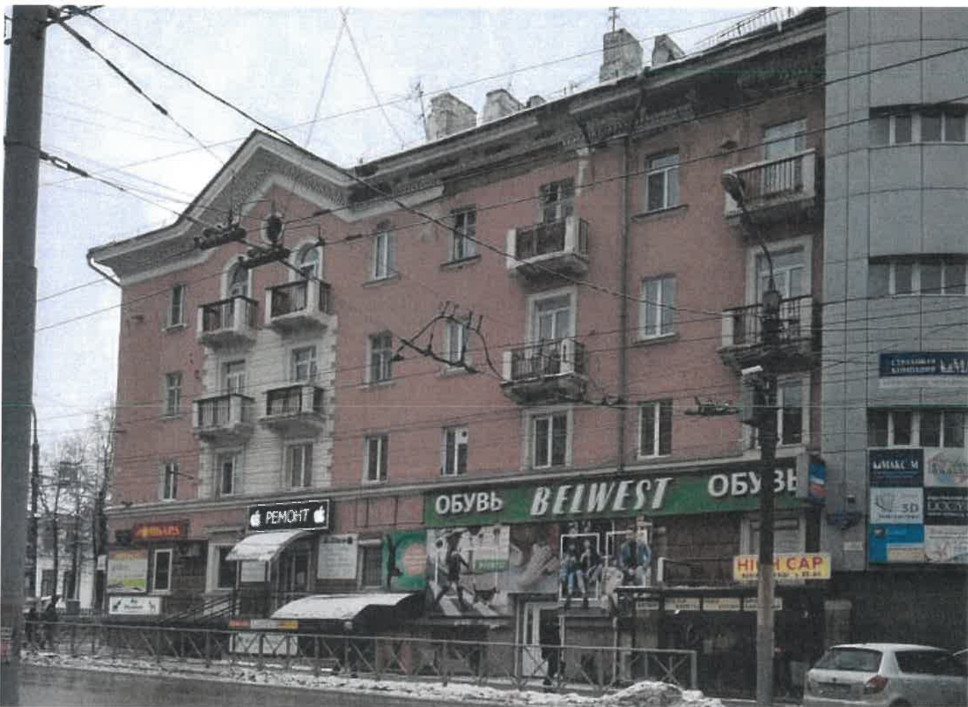
Существующее состояние бокового фасада по ул. Пушкина
