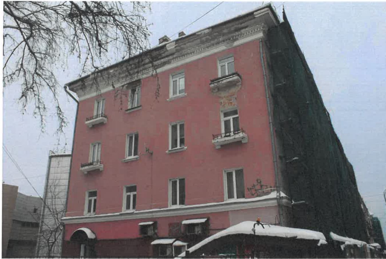
Существующее состояние бокового фасада по ул. Комсомольский проспект
