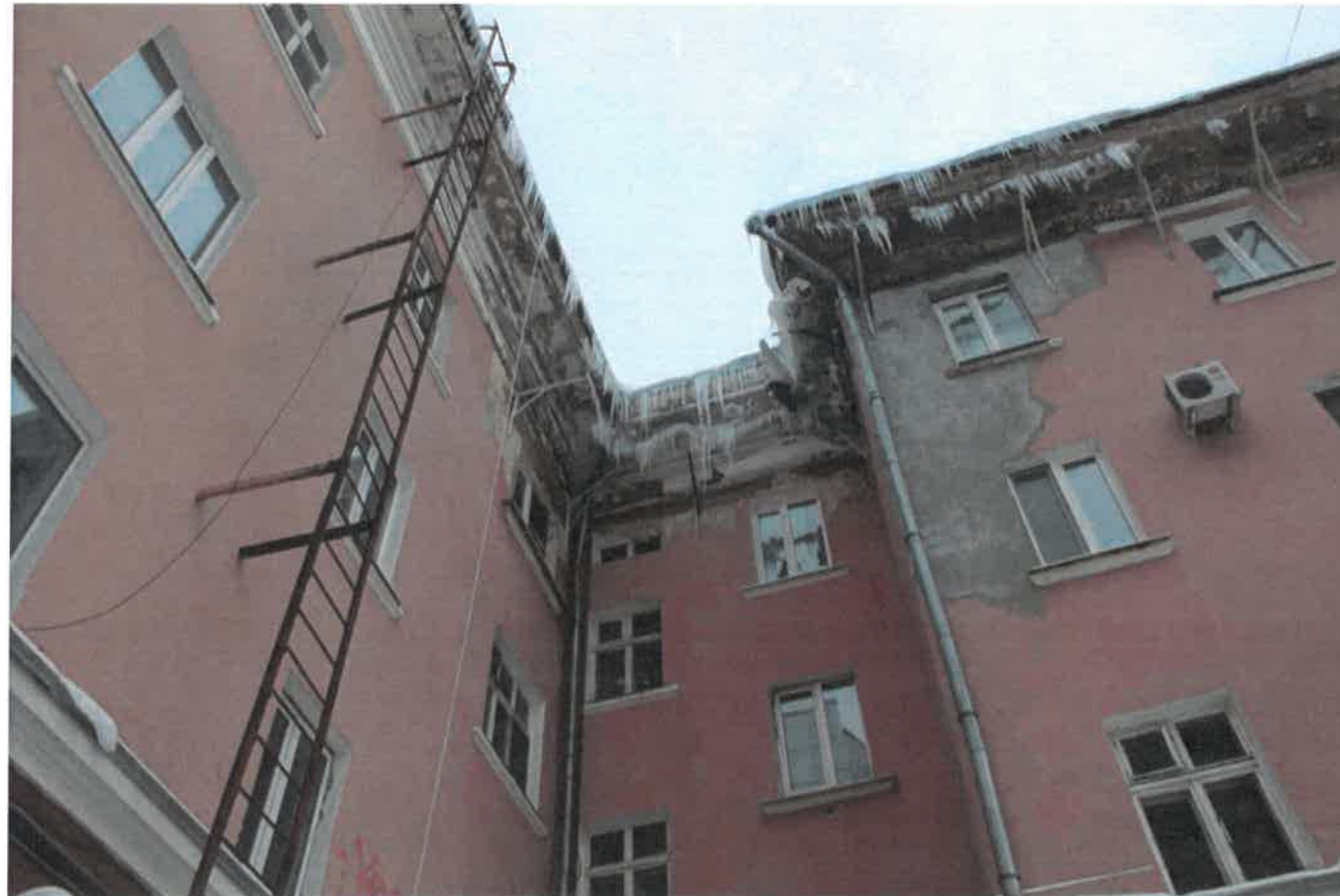
Существующее состояние дворового фасада по ул. Комсомольский проспект
