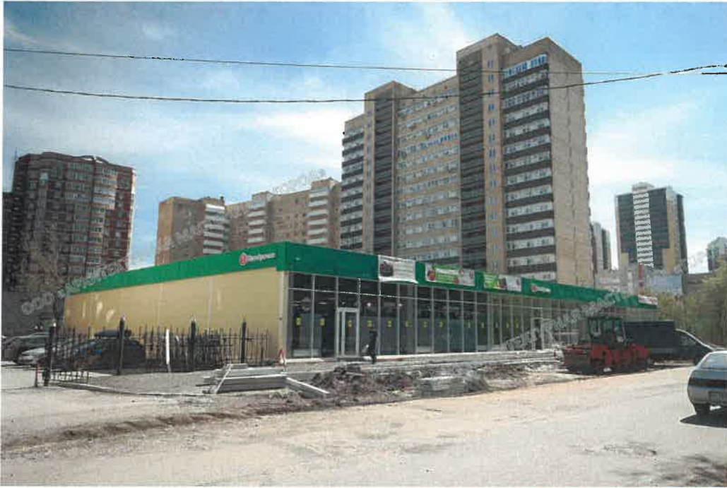
Главный фасад по ул. М. Горького в осях 1-3 и боковой фасад в осях В-А
