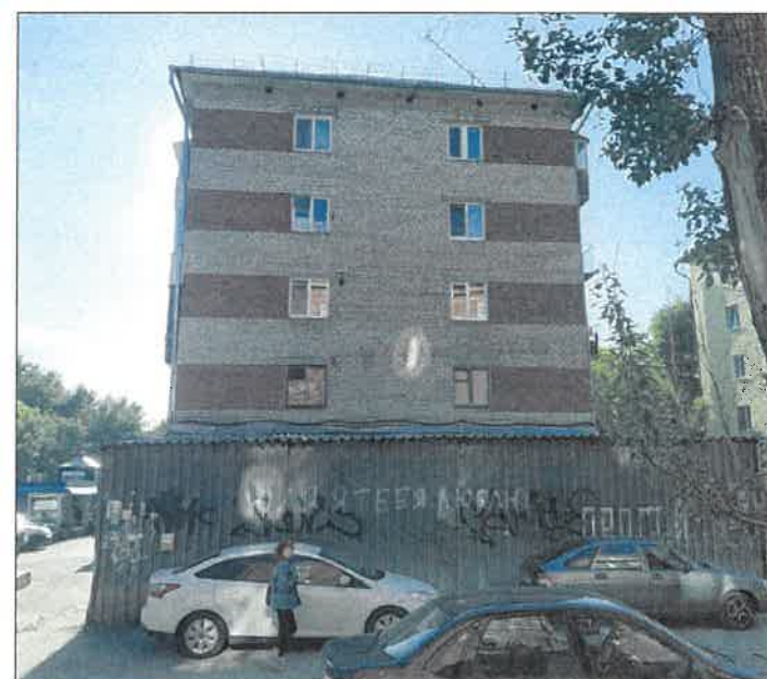
Боковой фасад со стороны ул. Куйбышева
