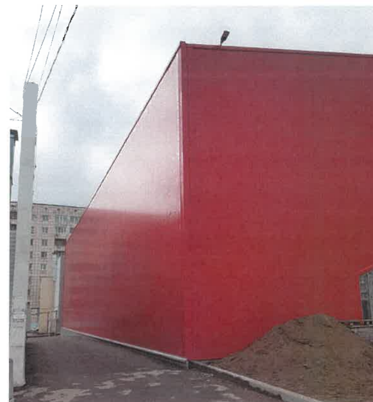
Существующее состояние дворового фасада (фотофиксация)
