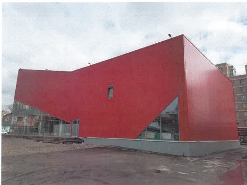
Существующее состояние главного фасада (фотофиксация)
