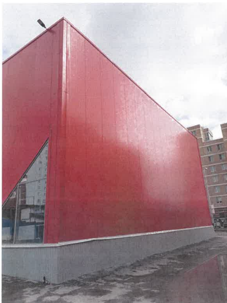
Существующее состояние бокового фасада (фотофиксация)
