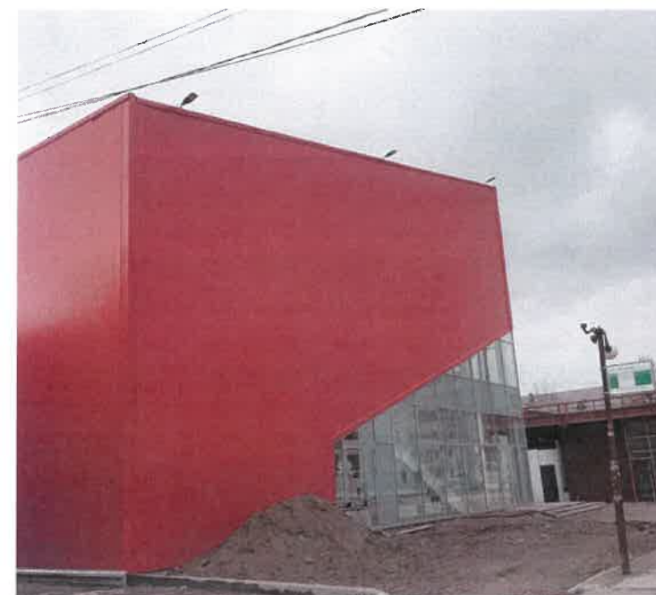
Существующее состояние бокового фасада (фотофиксация)
