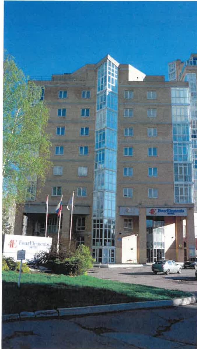
Главный фасад по улице Мира
