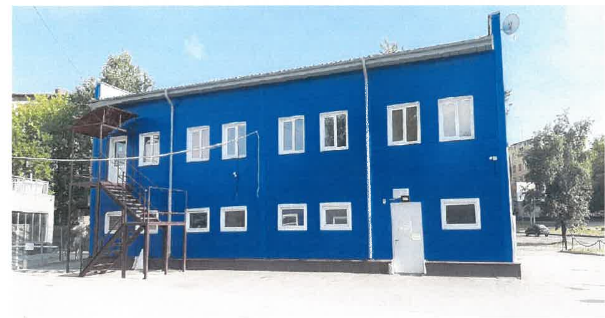
Существующее состояние бокового фасада
