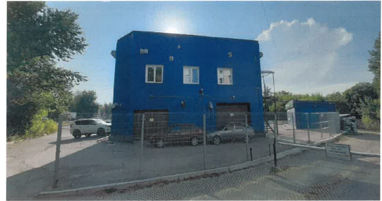
Существующее состояние дворового фасада
