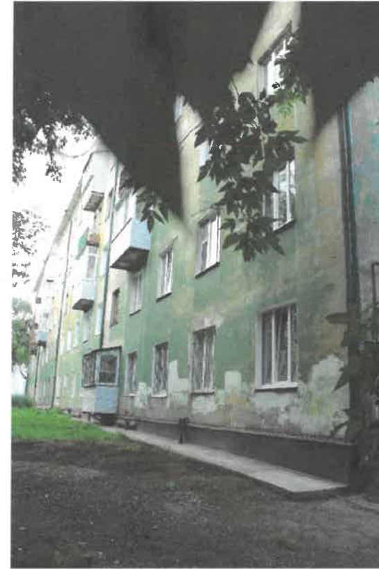
Существующее состояние главного фасада
