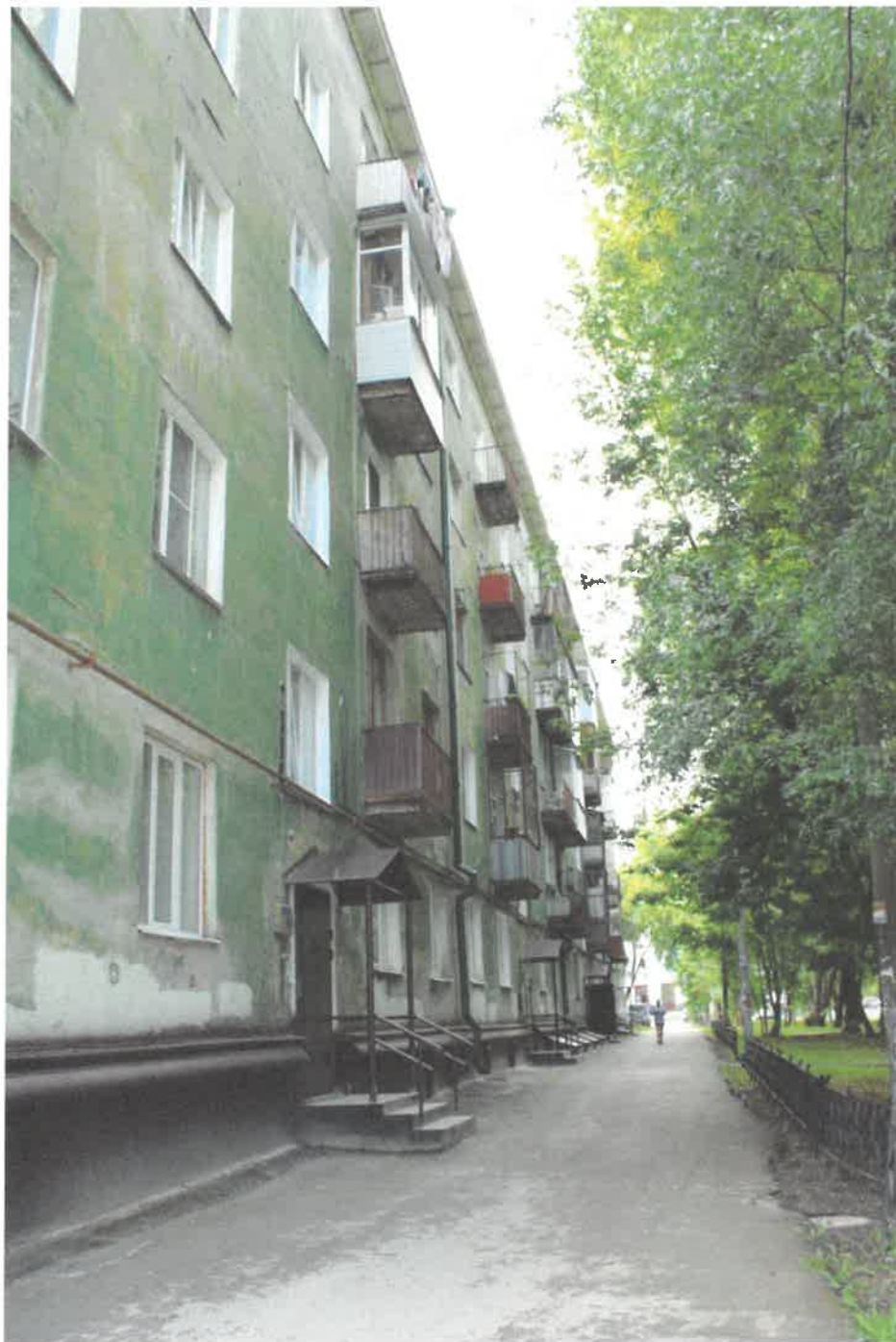
Существующее состояние дворового фасада
