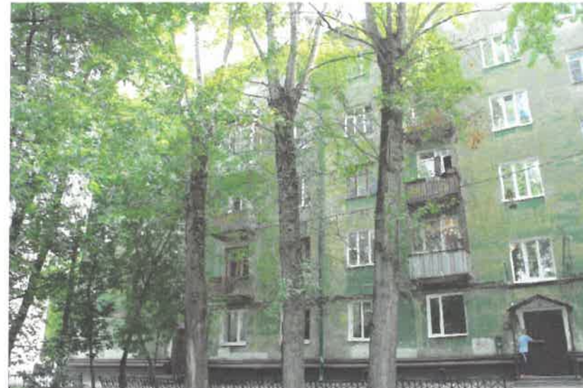
Существующее состояние дворового фасада
