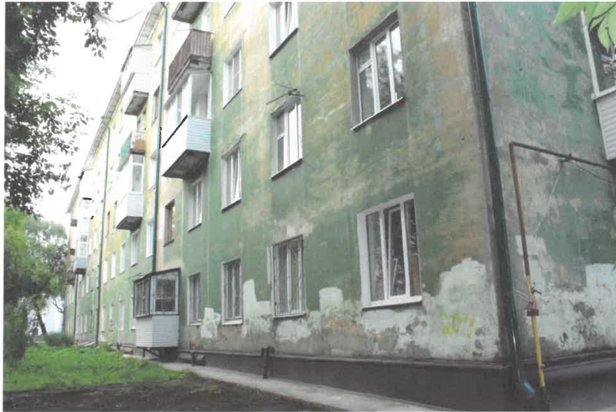
Существующее состояние главного фасада
