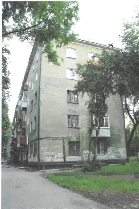
Существующее состояние бокового фасада
