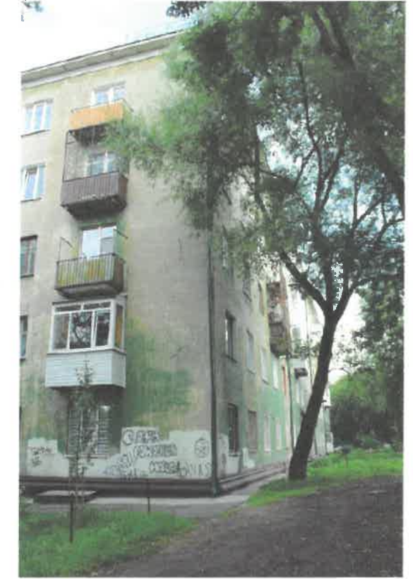
Существующее состояние главного фасада
