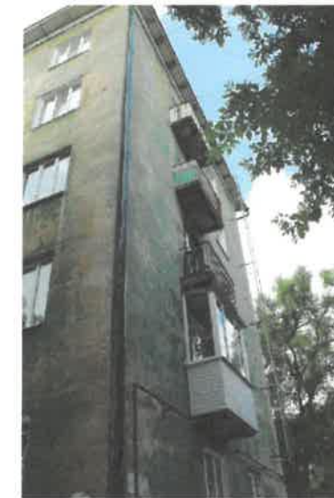
Существующее состояние бокового фасада
