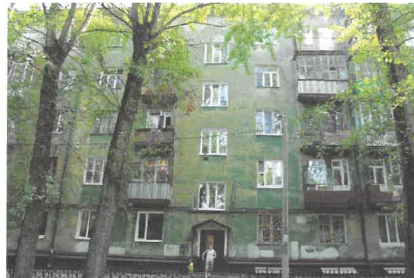
Существующее состояние дворового фасада
