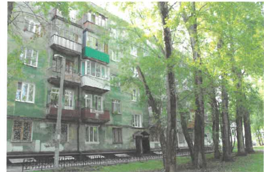
Существующее состояние дворового фасада
