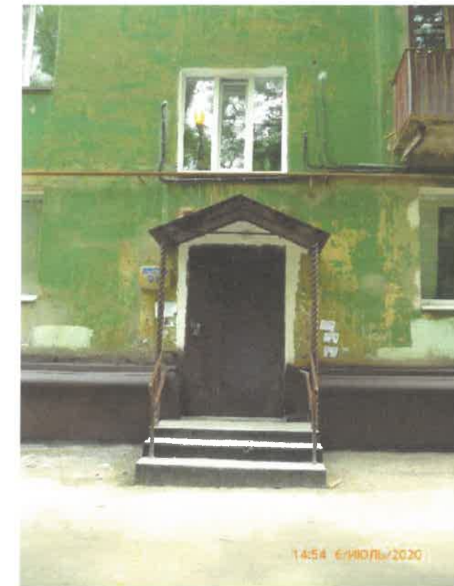
Существующее состояние дворового фасада Крыльцо подъезда
