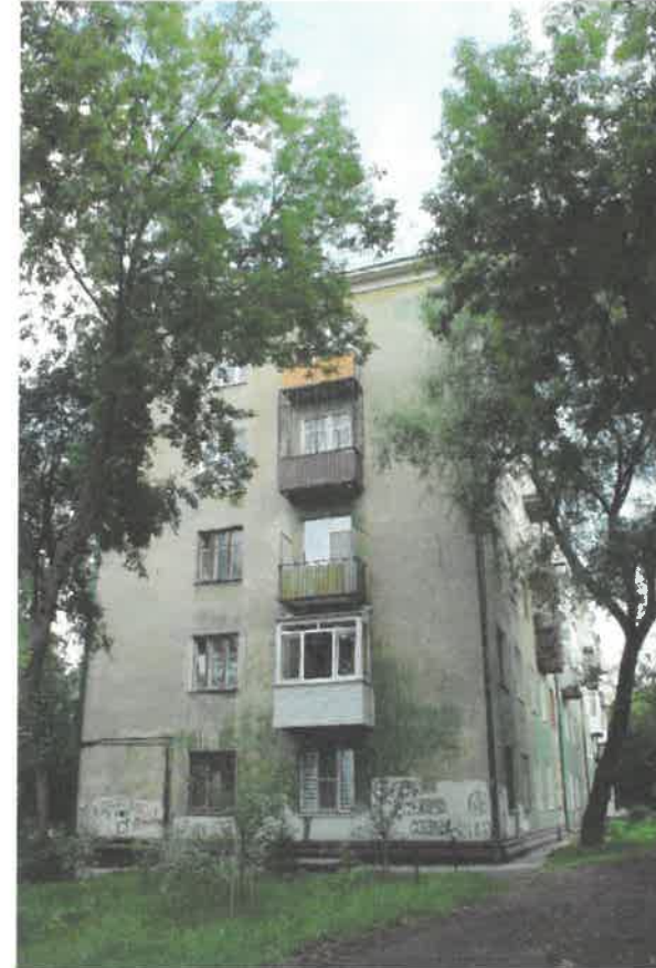
Существующее состояние бокового фасада
