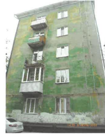
Существующее состояние бокового фасада
