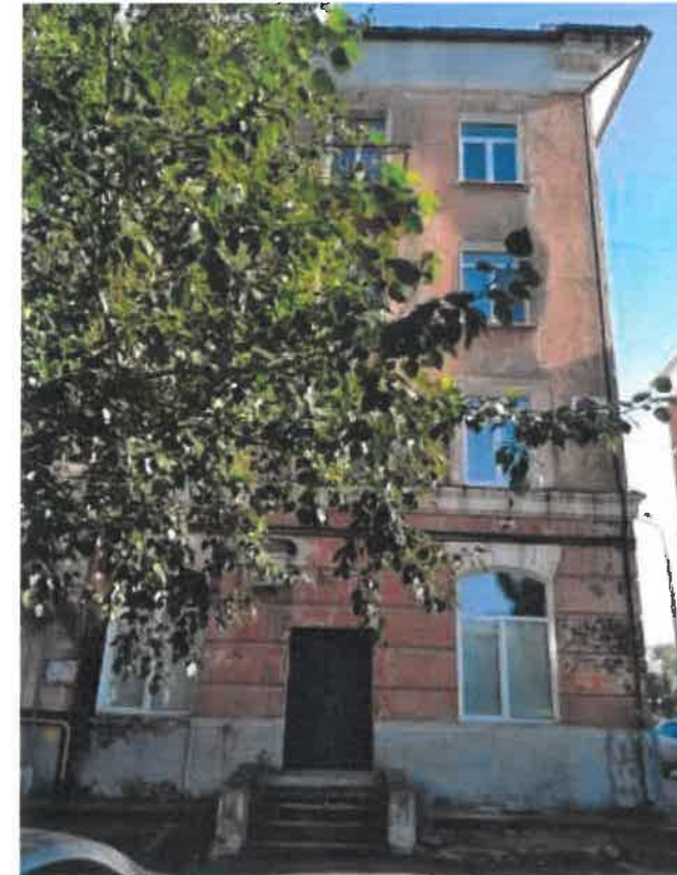
Дворовой (северный) фасад
