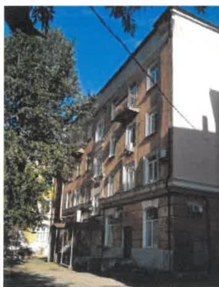
Дворовой (северный) фасад
