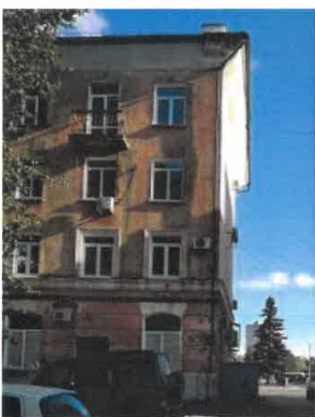
Дворовой (северный) фасад
