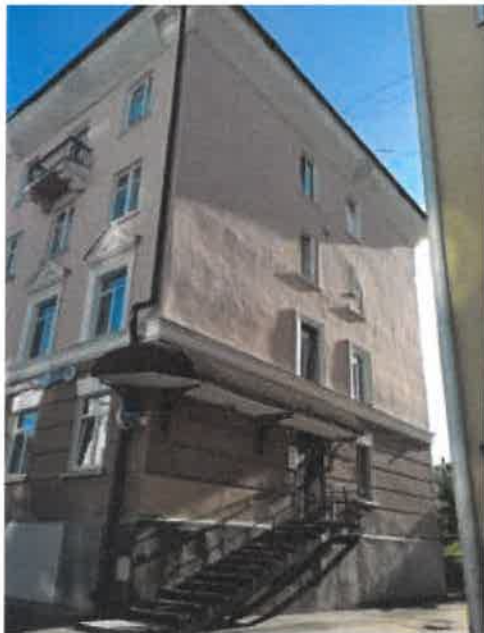
Дворовой (северный) фасад
