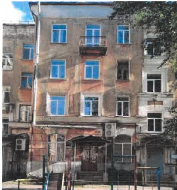
Дворовой (северный) фасад
