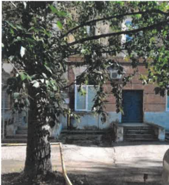
Дворовой (северный) фасад
