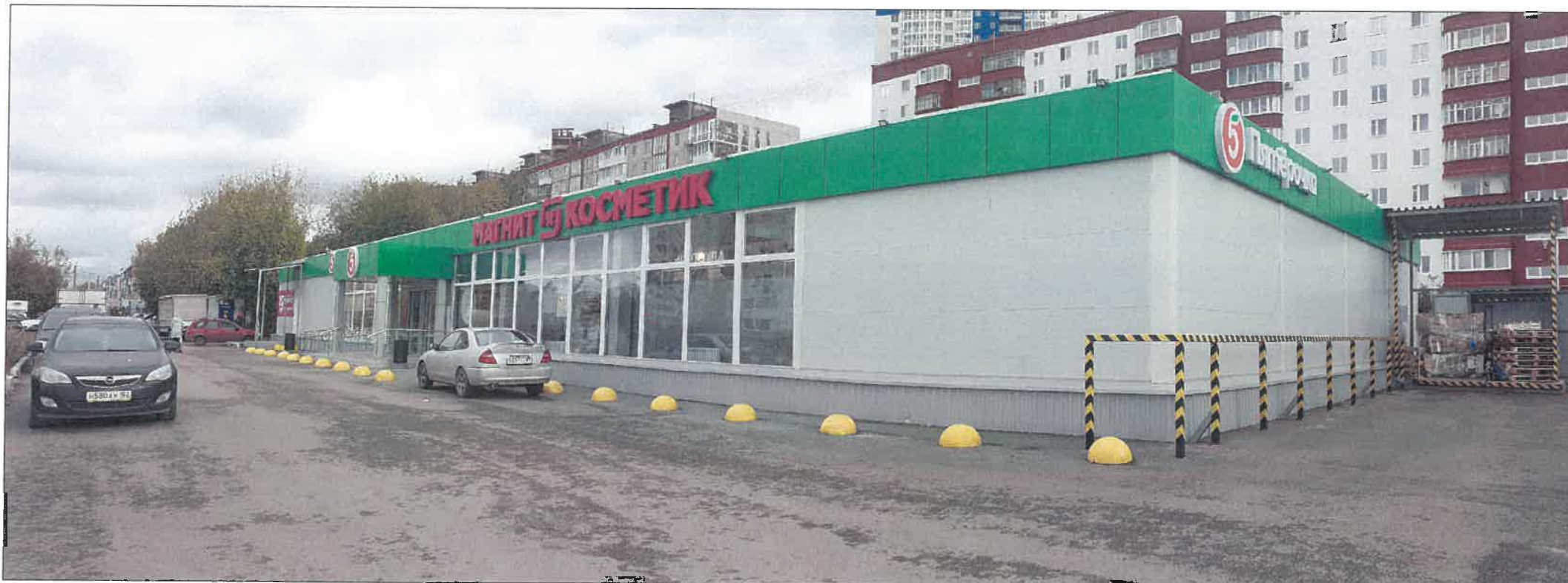
Главный фасад по ул. Мира
