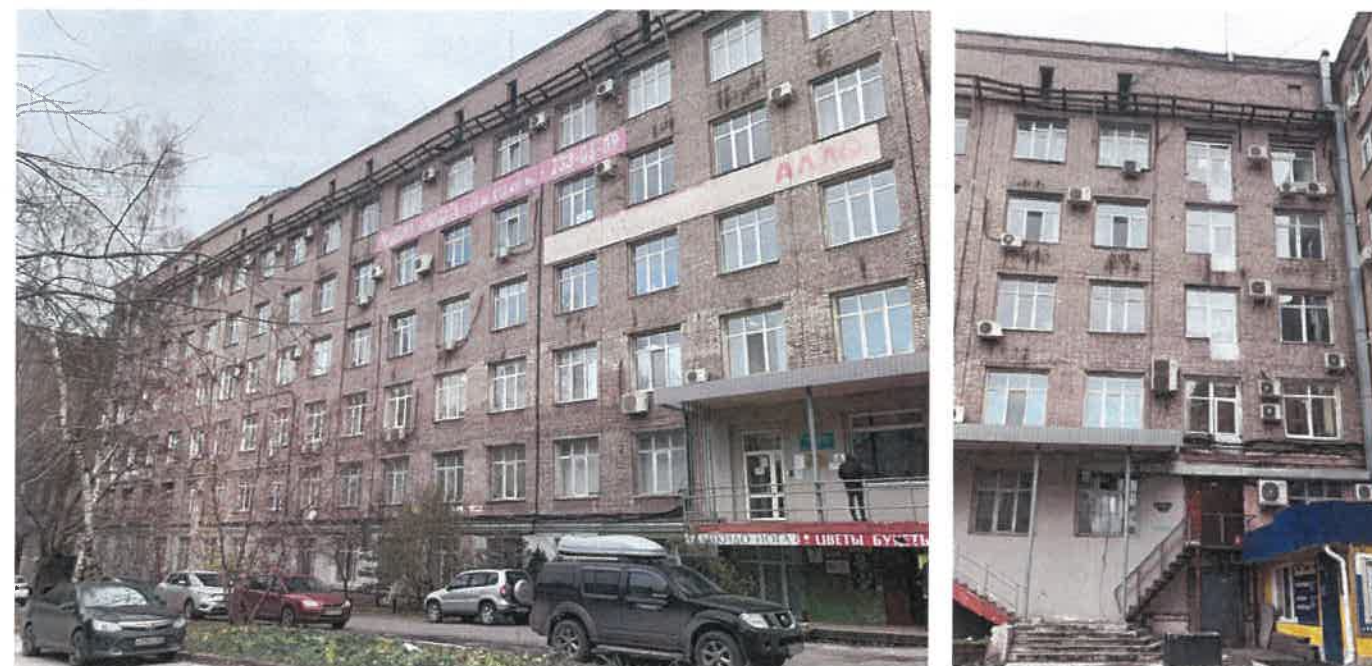
Существующее состояние бокового фасада (фотофиксация)
