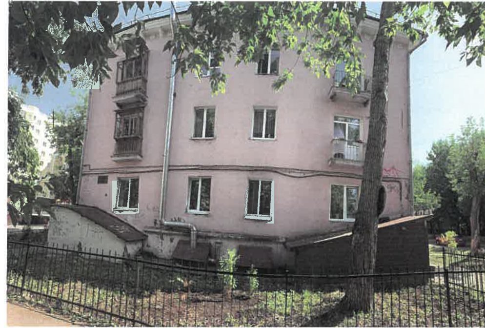
Боковые фасады в осях (2-1, 1-2) (существующее положение)
