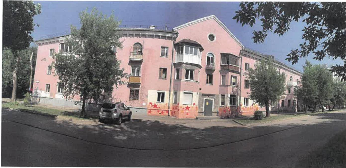
Главный фасад (в осях А-Б) (существующее положение)
