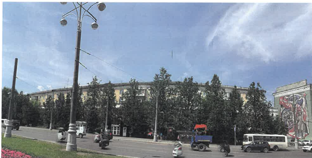
Главный фасад (в осях А-Б) со стороны Комсомольского проспекта (существующее положение)
