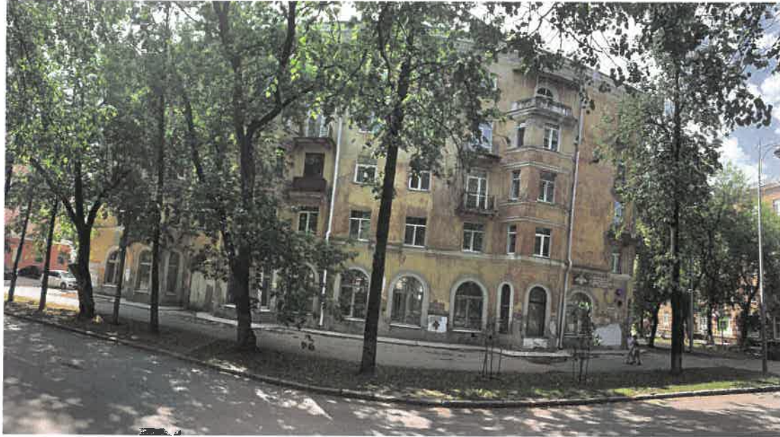
Главный фасад (в осях 6-1; со стороны Комсомольского проспекта) (существующее положение)
