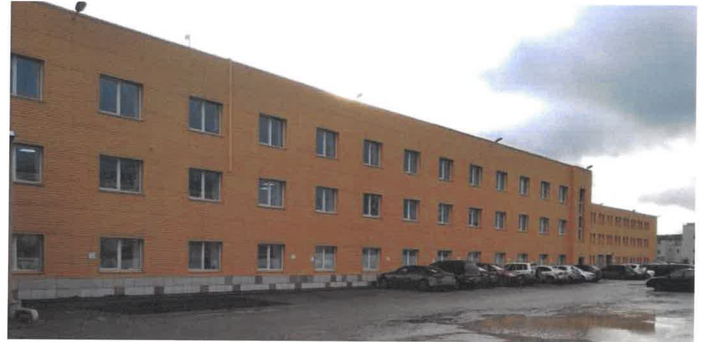
Боковой фасад (фасад со стороны ул. Уденская)
