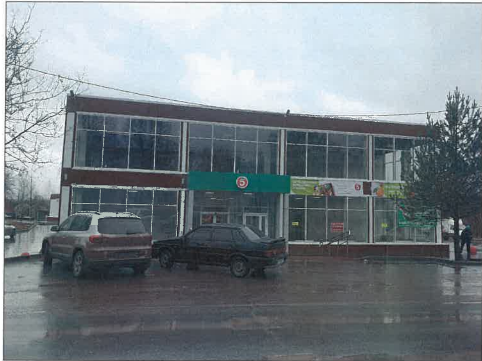
Главный фасад по ул. Лядовская
