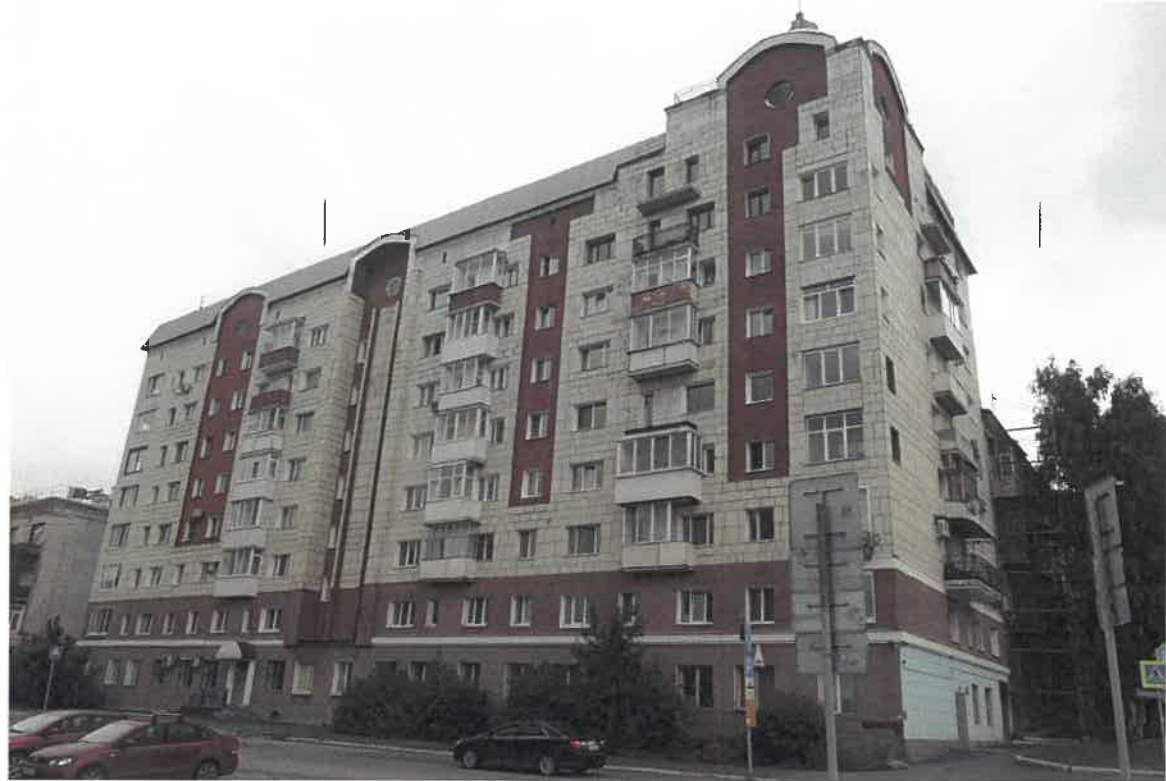
Главный фасад в осях 1-4 (существующее положение)
