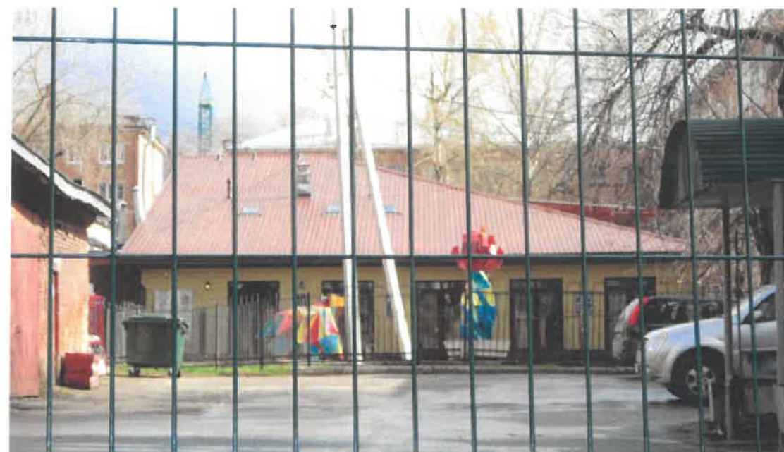
Существующее состояние бокового фасада до реконструкции
