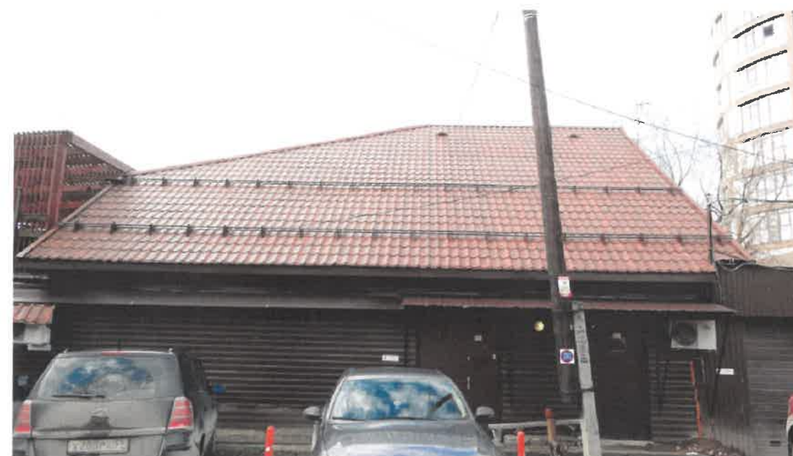
Существующее состояние бокового фасада до реконструкции
