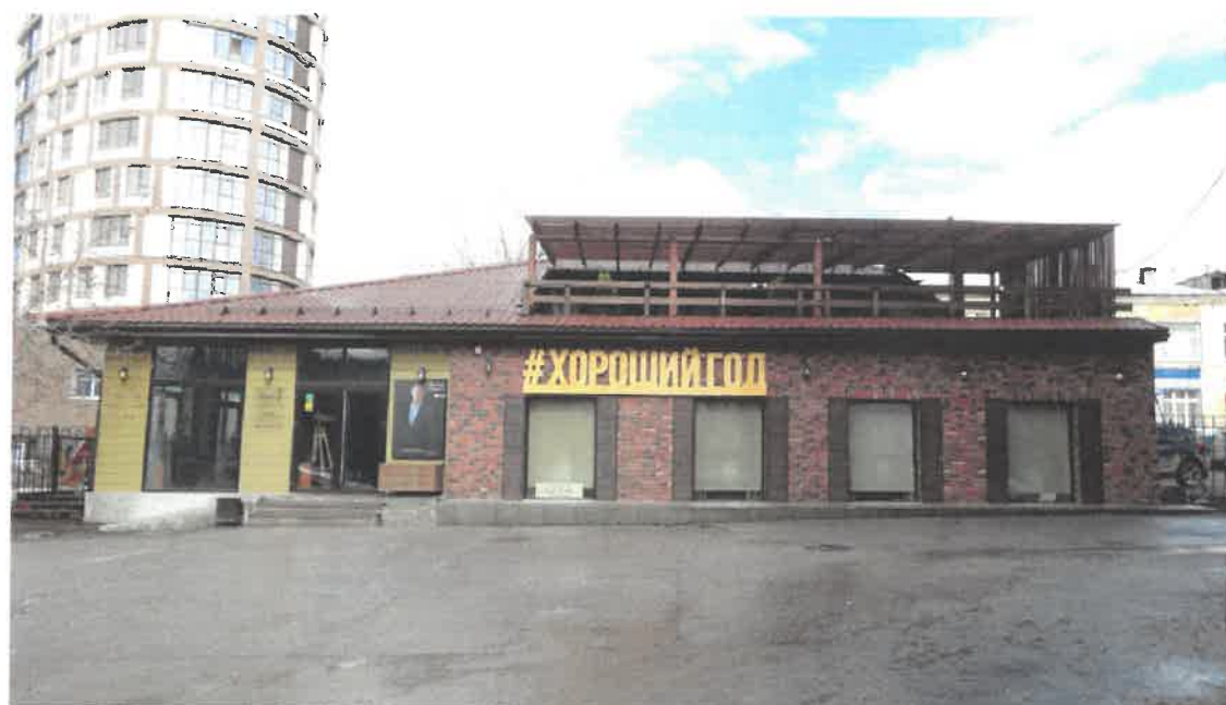
Существующее состояние главного фасада до реконструкции
