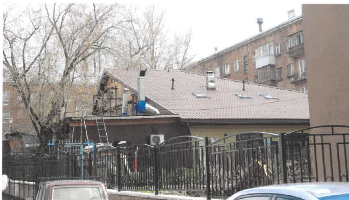
Существующее состояние дворового фасада до реконструкции
