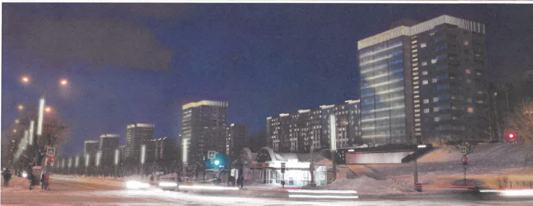
МАКСИМАЛЬНАЯ МОЩНОСТЬ (ДЛЯ КАЖДОГО ДОМА)- 15 кВт
