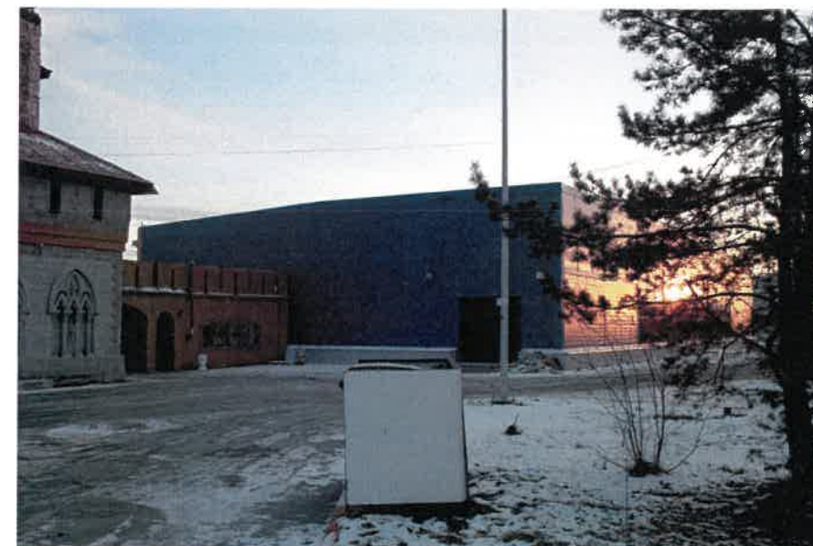
Боковой фасад левого крыла (со стороны ул. Спешилова)
