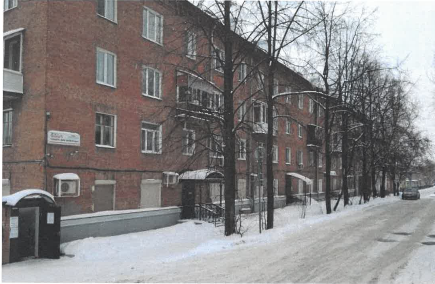
Главный фасад со стороны ул. Пермская
