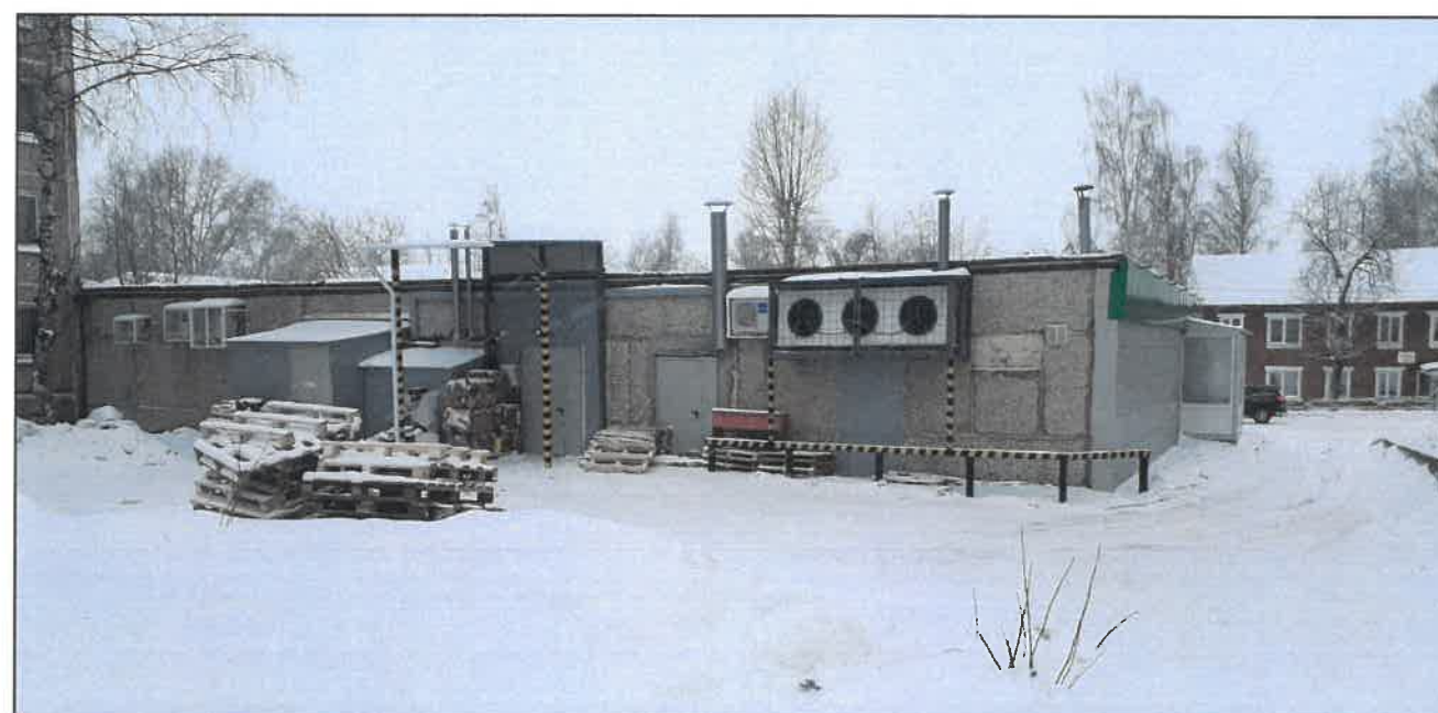
Дворовой фасад (Вид с точки Г)
